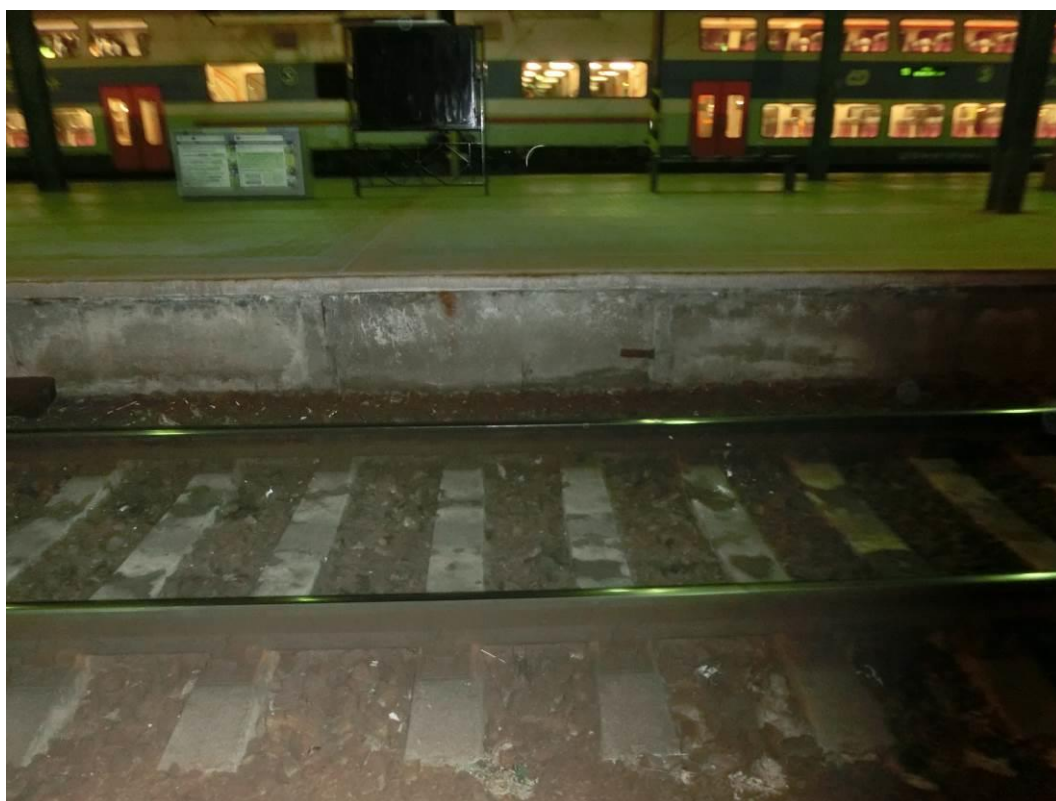
Foto. 97: Pohled na nástupištní zídku – patrná lokální koroze výztuže, degradace povrchu
