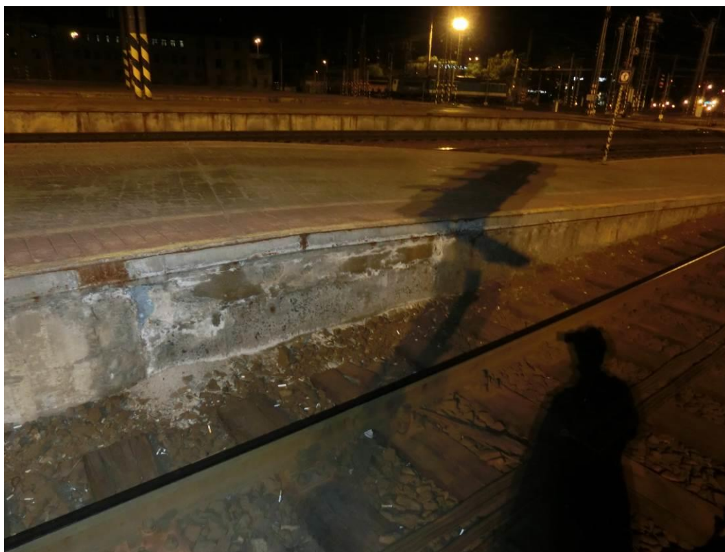
Foto. 114: Degradace krycí vrstvy betonu, odpadávání
