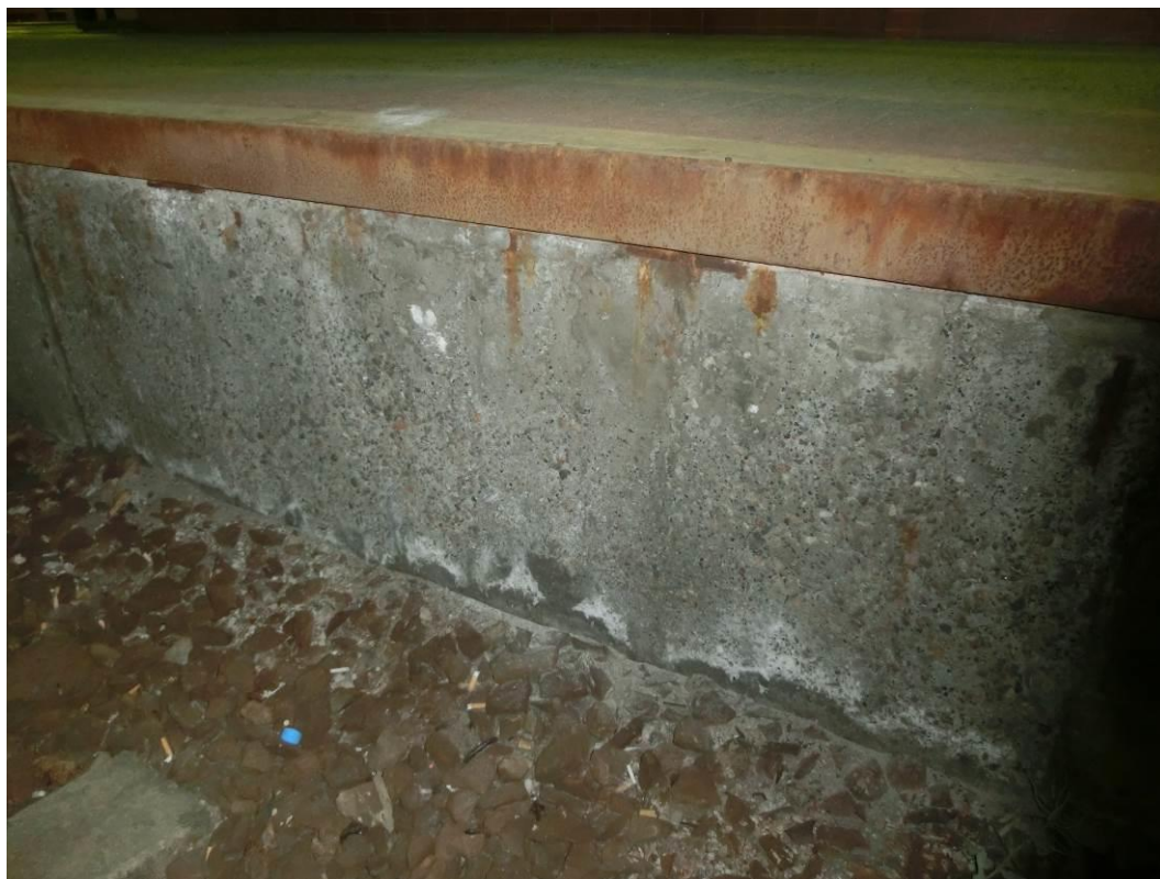
Foto. 49: Plošná koroze ocelového úhelníku, degradace krycí vrstvy betonu
