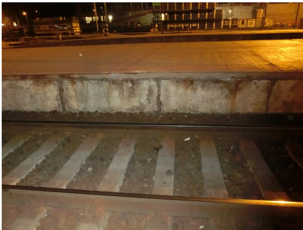
Foto. 54: Pohled na nástupištní zídku – patrná lokální koroze výztuže, degradace povrchu
