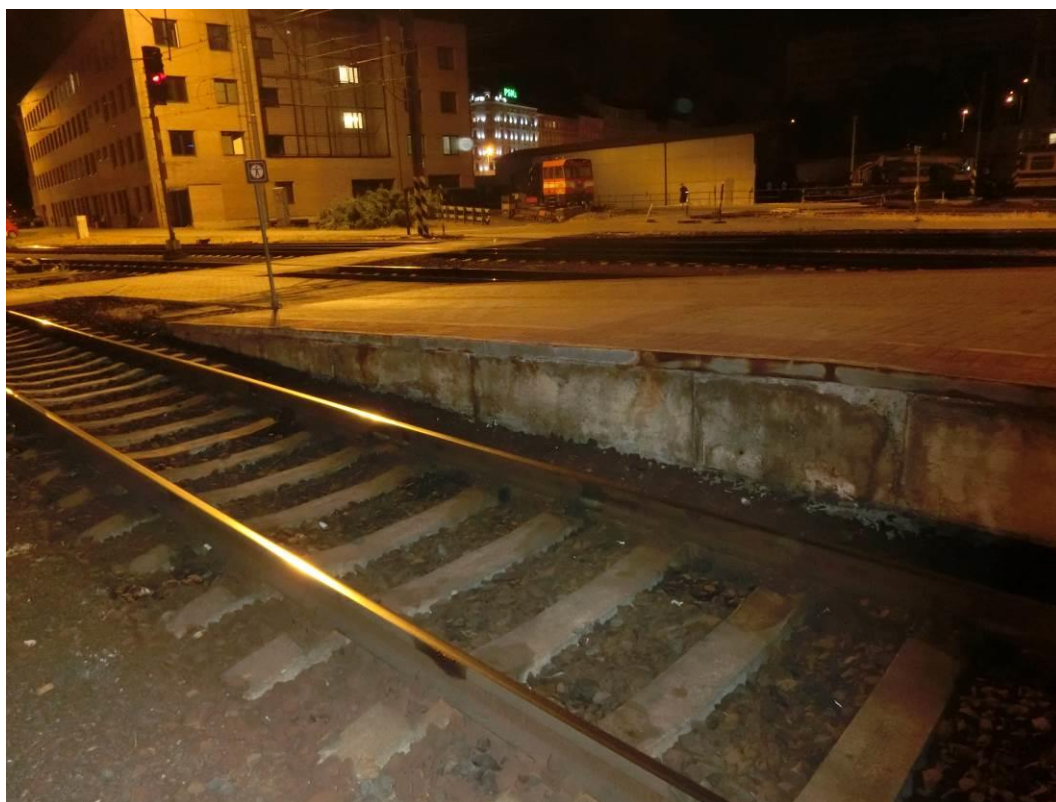
Foto. 56: Pohled na nástupištní zídku – patrná lokální koroze výztuže, degradace betonu
