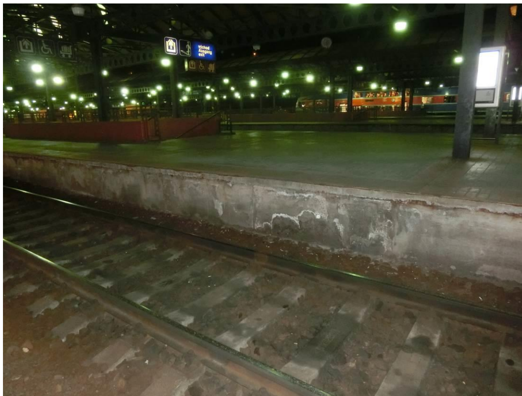
Foto. 5: Pohled na nástupištní zídku – degradace krycí vrstvy betonu - lokální odpadávání betonu, lokální koroze výztuže a ocelového úhelníku
