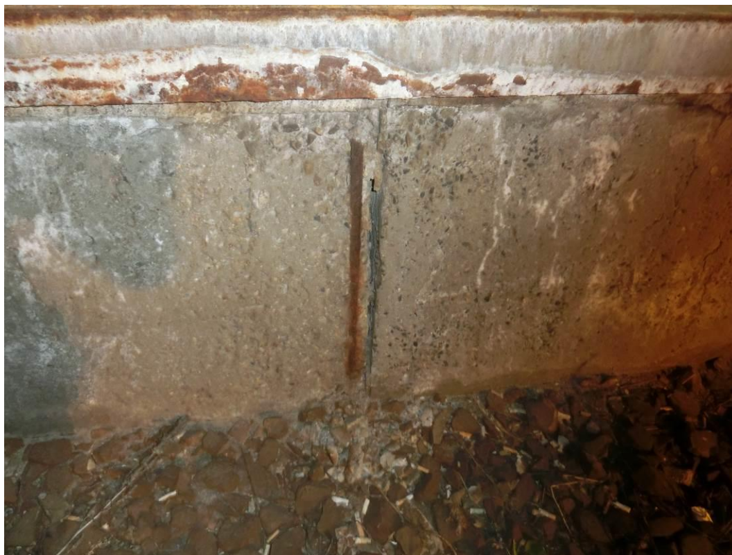
Foto. 107: Detail koroze výztuže
