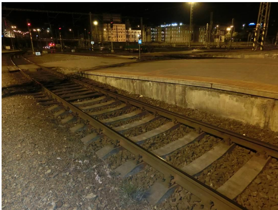
Foto. 93: Pohled na nástupištní zídku – patrná lokální koroze výztuže, degradace povrchu
