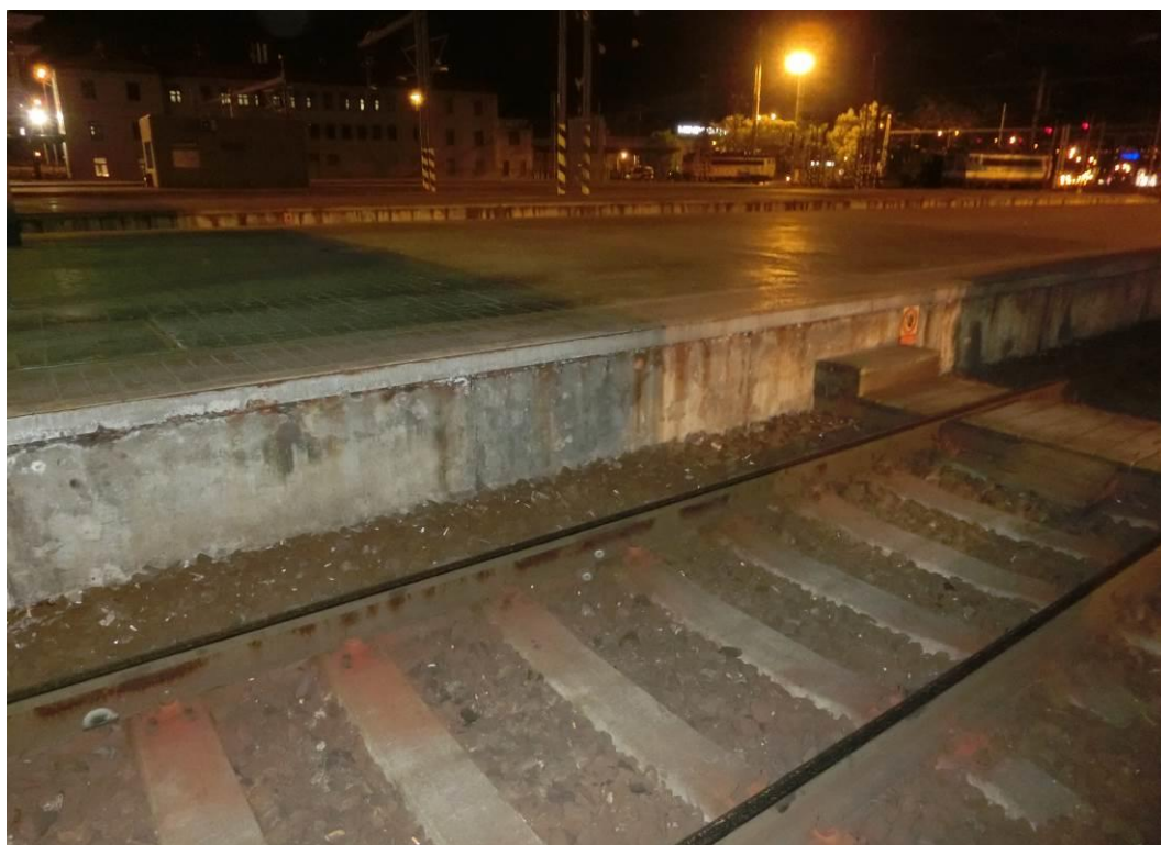
Foto. 36: Pohled na nástupištní zídku – patrná lokální koroze výztuže, degradace krycí vrstvy betonu
