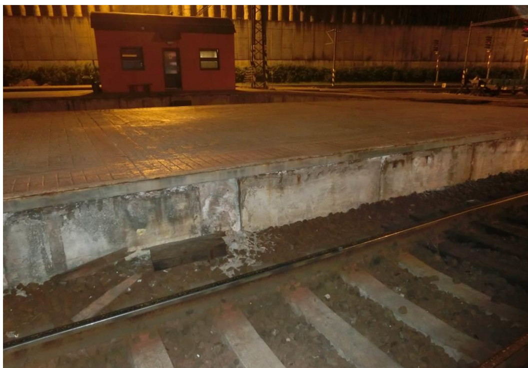
Foto. 2: Pohled na nástupištní zídku – degradace krycí vrstvy betonu - lokální odpadávání betonu, lokální koroze výztuže a ocelového úhelníku
