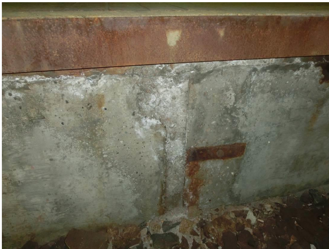
Foto. 63: Detail odpadnuté krycí vrstvy betonu
