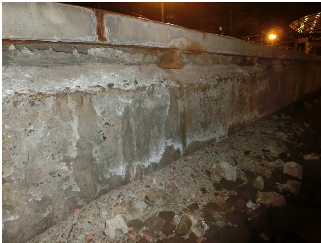
Foto. 91: Detail degradace betonu pod zkorodovaným vrstvy
