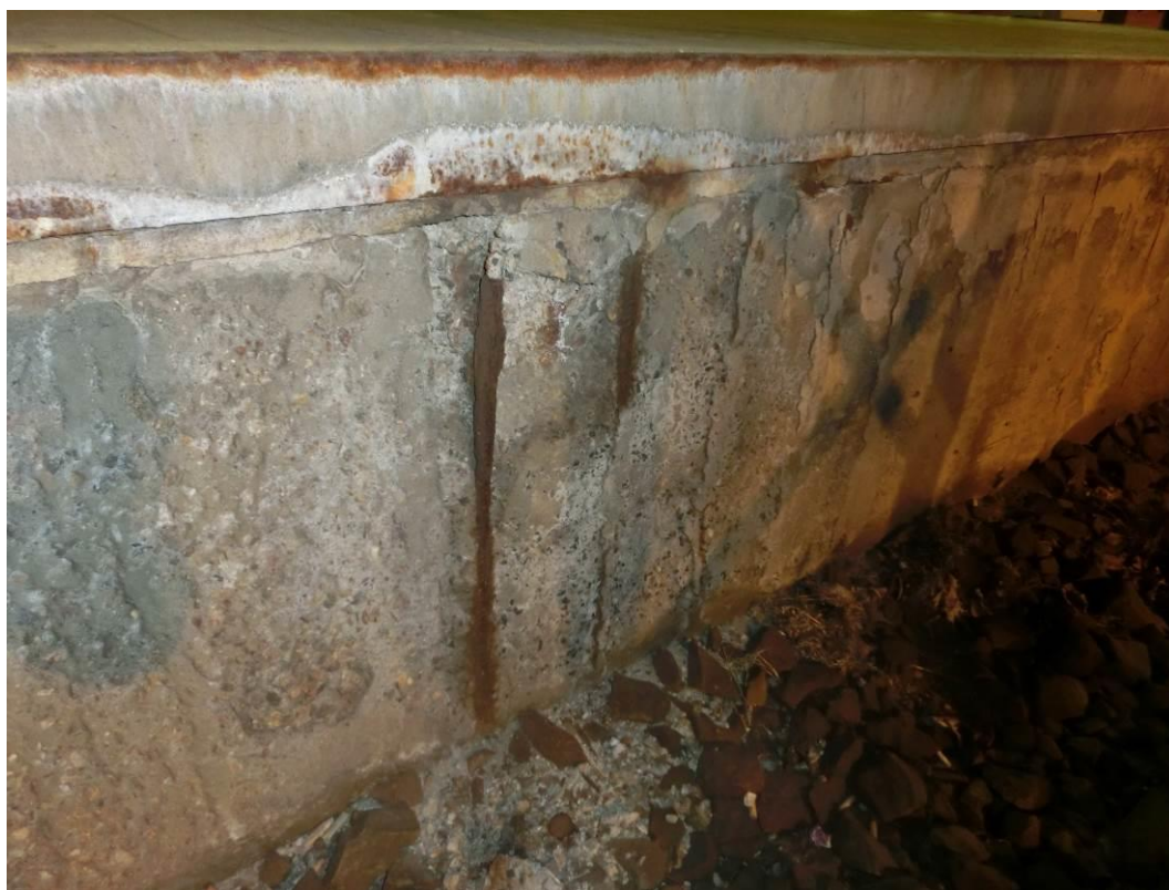
Foto. 108: Detail koroze výztuže
