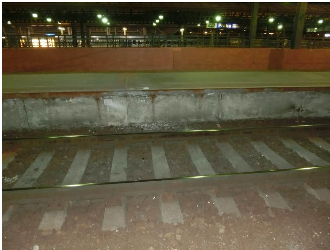
Foto. 67: Pohled na nástupištní zídku – patrná degradace krycí vrstvy betonu
