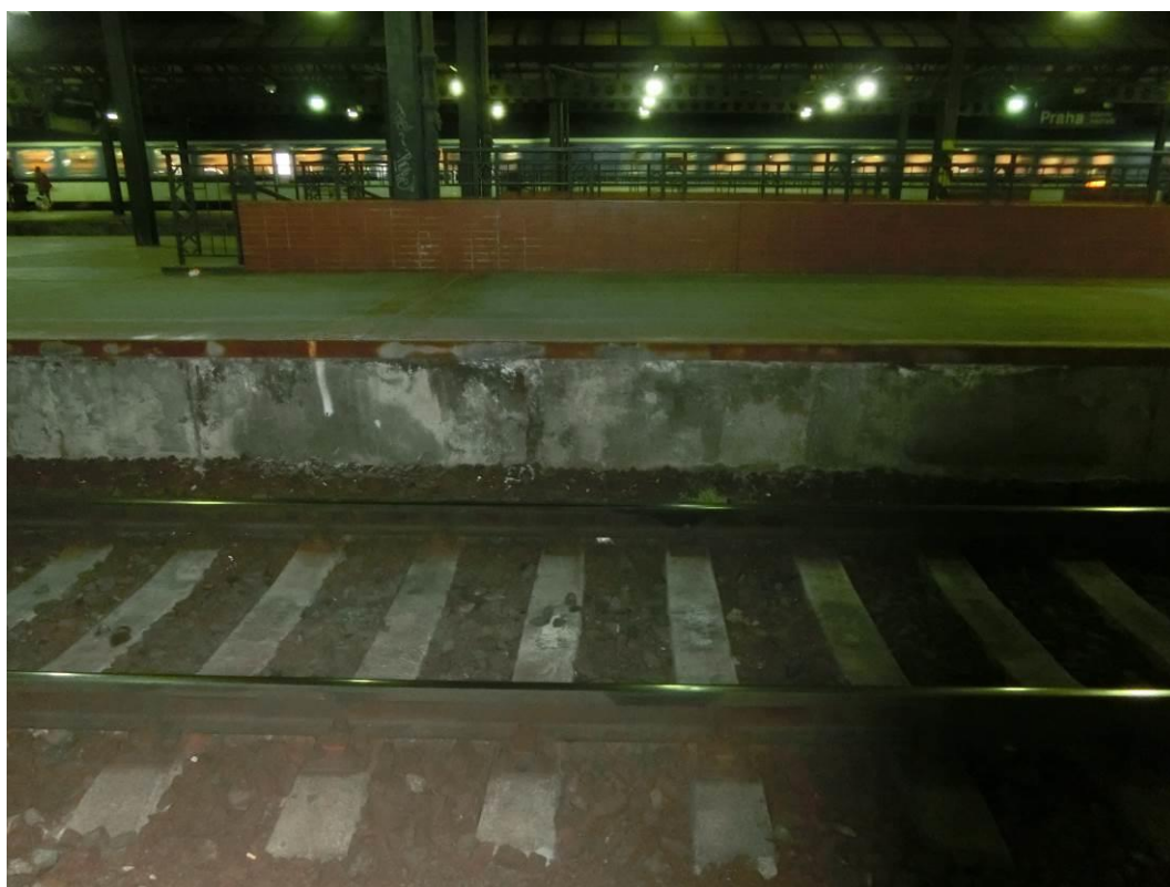
Foto. 45: Pohled na nástupištní zídku – patrná degradace krycí vrstvy betonu
