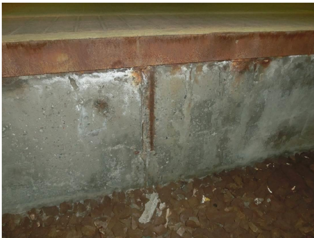
Foto. 68: Detail degradace krycí vrstvy betonu, lokální koroze výztuže
