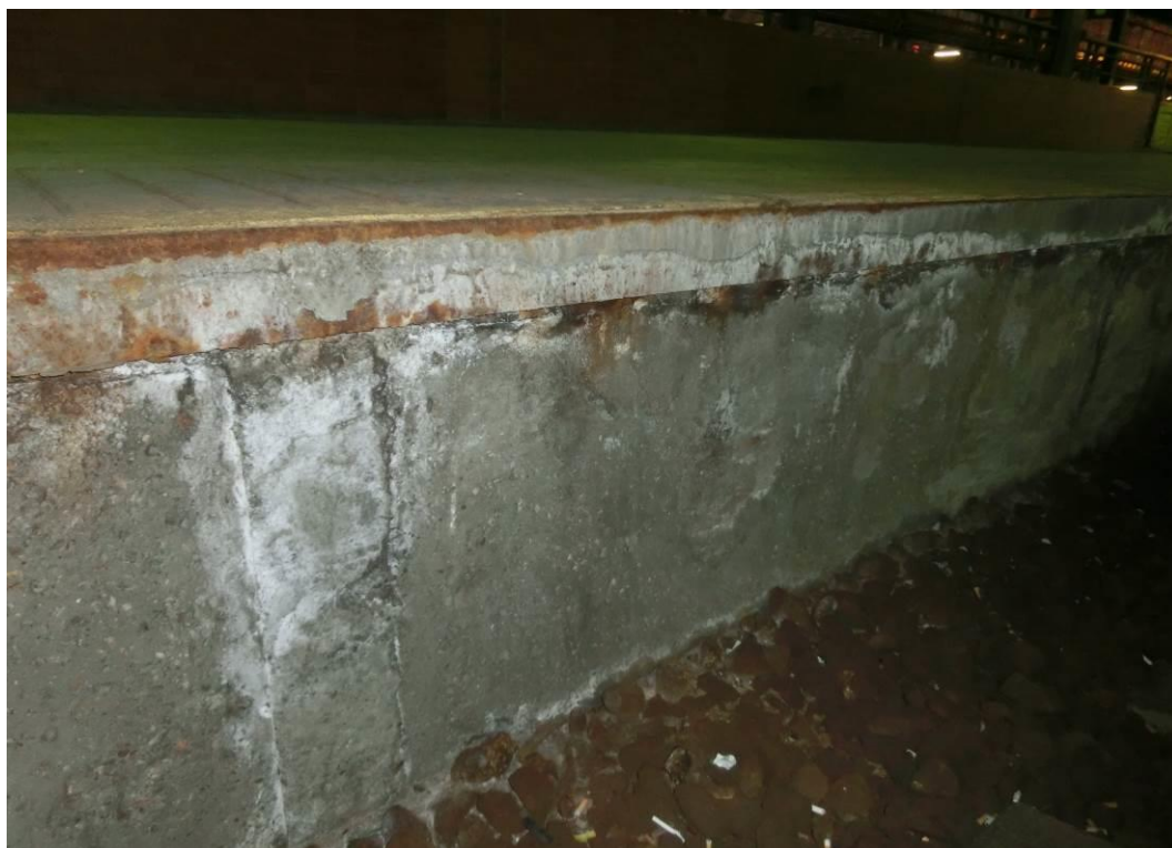
Foto. 28: Detail degradace krycí vrstvy betonu
