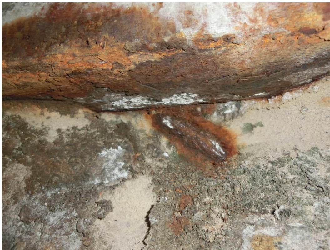
Foto. 31: Detail lokální koroze ocelové výztuže a ocelového úhelníku
