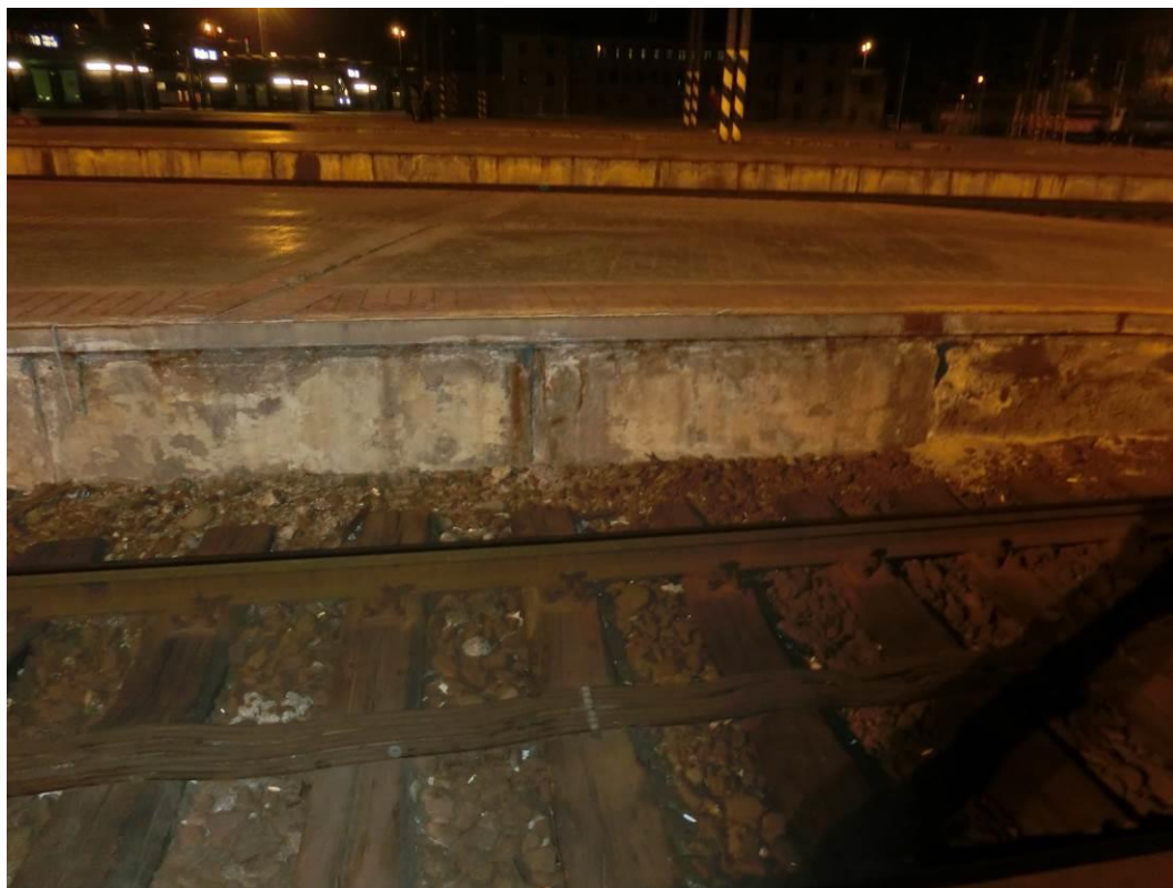
Foto. 113: Patrná lokální koroze výztuže, degradace krycí vrstvy betonu, odpadávání
