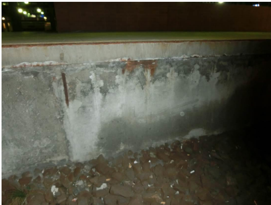
Foto. 101: Lokální koroze výztuže, plošná koroze ocelovéhoúhelníku
