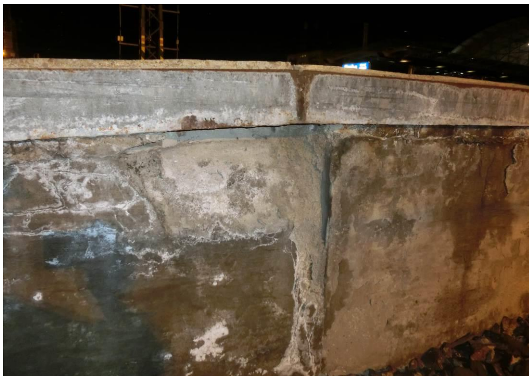
Foto. 20: Detail degradace krycí vrstvy betonu
