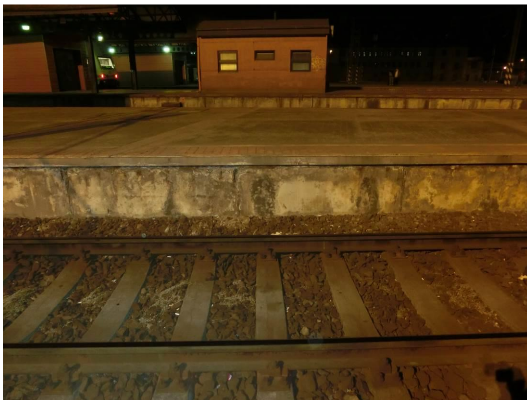
Foto. 112: Pohled na nástupištní zídku – patrná degradace krycí vrstvy betonu
