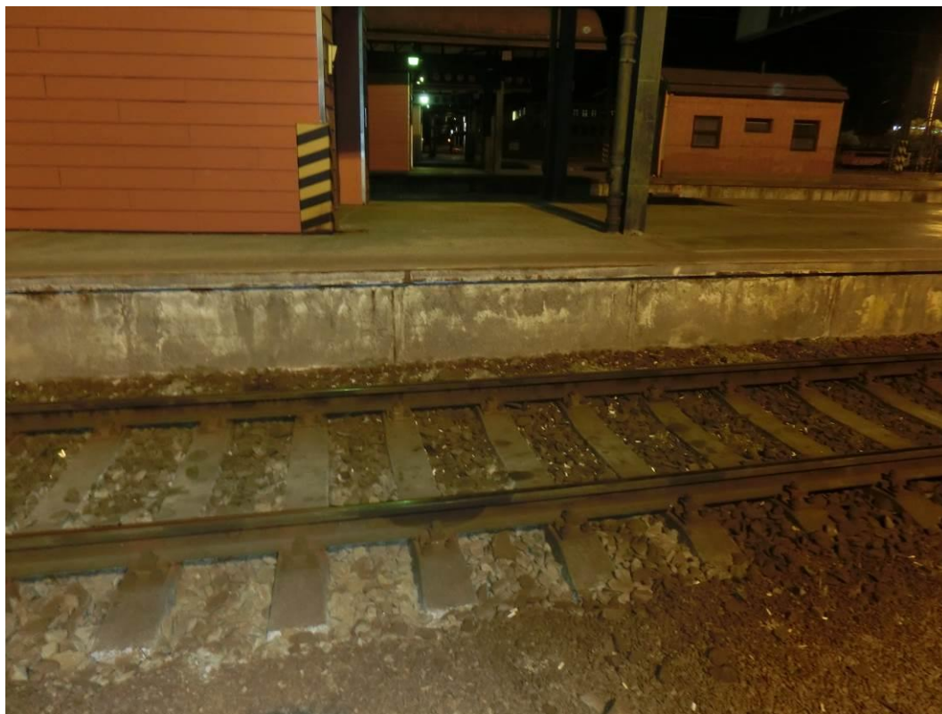
Foto. 111: Pohled na nástupištní zídku – patrná degradace krycí vrstvy betonu
