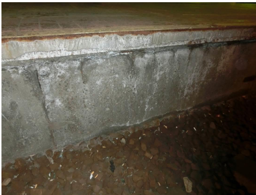
Foto. 96: Detail degradace horní vrstvy betonu – prokreslení výztuže
