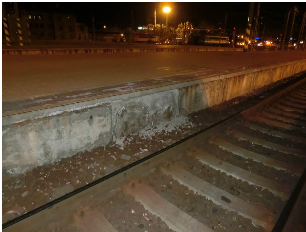
Foto. 37: Pohled na nástupištní zídku – patrná degradace krycí vrstvy betonu
