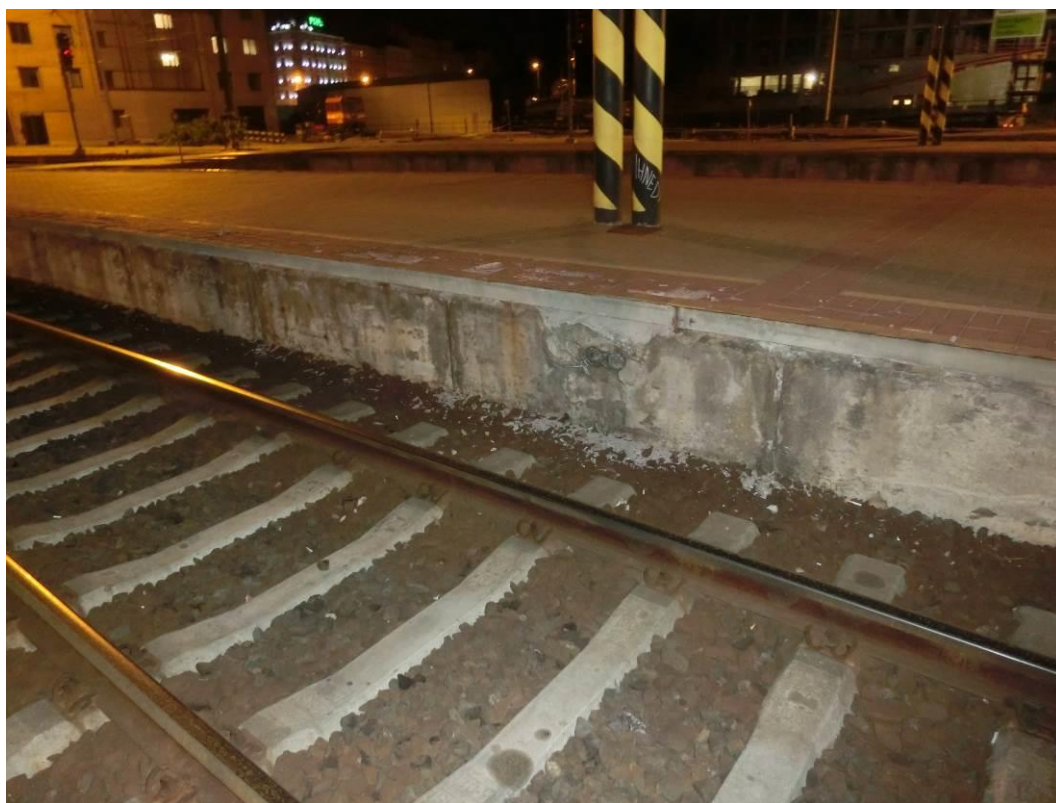
Foto. 16: Detail odpadávání krycí vrstvy betonu, koroze ocelového úhelníku
