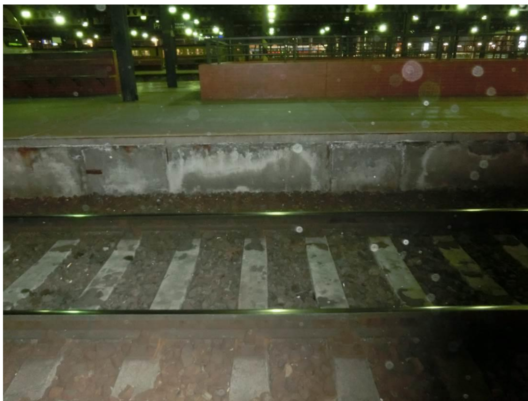
Foto. 100: Pohled na nástupištní zídku – patrná lokální koroze výztuže, degradace povrchu
