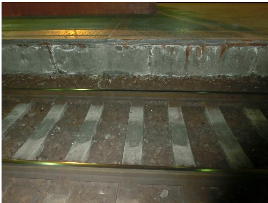
Foto. 84: Detail degradace betonu pod zkorodovaným ocelovým úhelníkem
