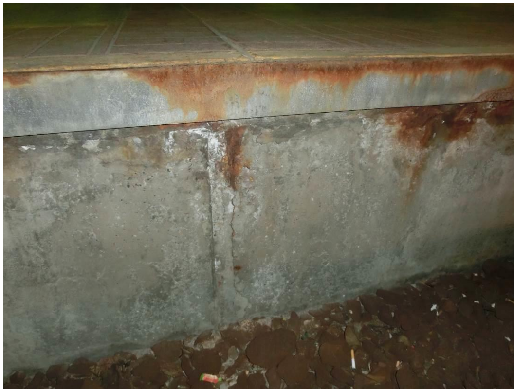
Foto. 61: Detail plošné koroze ocelového úhelníku, degradace betonu pod úhelníkem, lokální koroze výztuže
