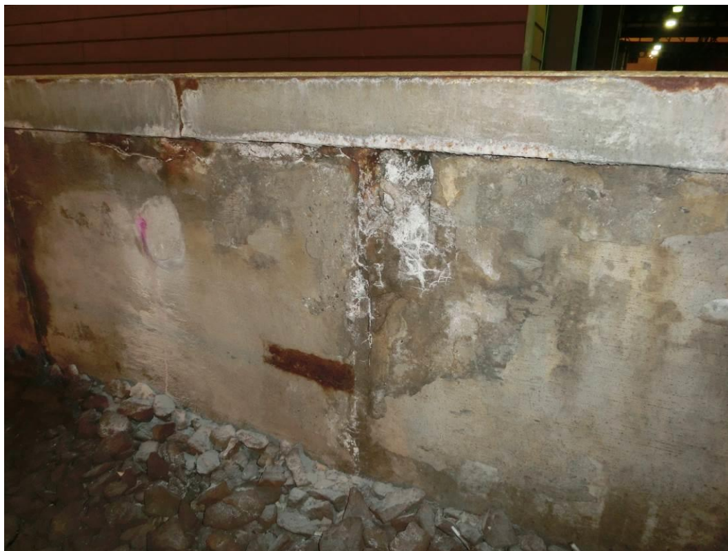
Foto. 13: Detail odpadávání krycí vrstvy betonu v místě styku dvou prefabrikátů, degradace betonu pod ocelovým úhelníkem
