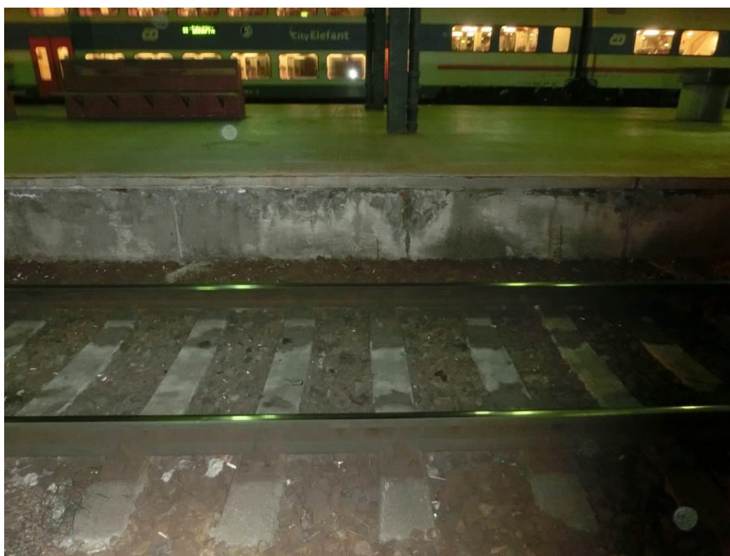
Foto. 98: Pohled na nástupištní zídku – patrná lokální koroze výztuže, degradace povrchu
