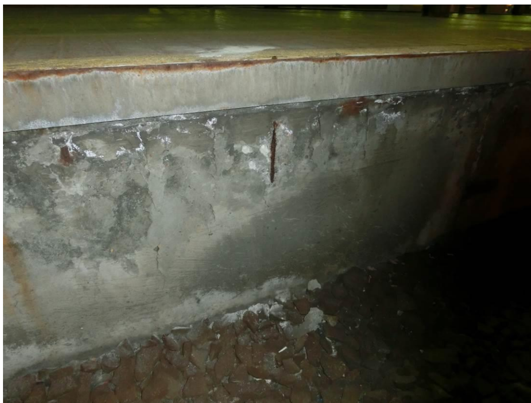
Foto. 102: Lokální koroze výztuže, plošná koroze ocelového úhelníku
