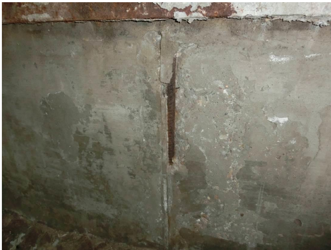
Foto. 7: Detail odhalené výztuže nástupištní zídky, koroze výztuže
