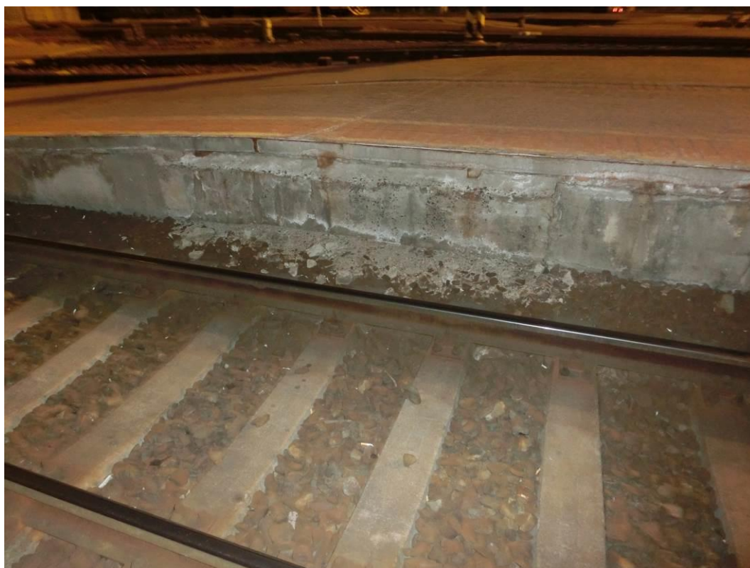
Foto. 90: Detail degradace betonu pod zkorodovaným vrstvy
