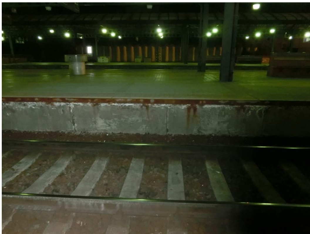
Foto. 44: Pohled na nástupištní zídku – patrná lokální koroze úhelníku, degradace krycí vrstvy betonu
