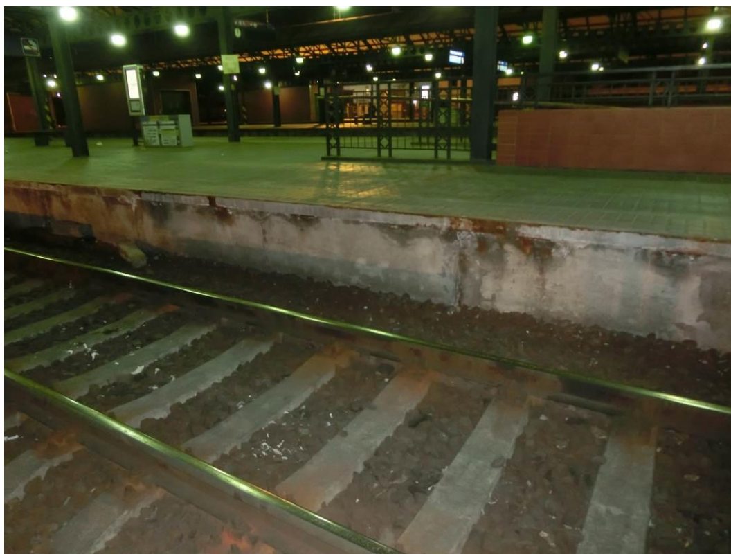
Foto. 12: Pohled na nástupištní zídku – degradace krycí vrstvy betonu, lokální odpadávání krycí vrstvy, lokální koroze výztuže a ocelového úhelníku
