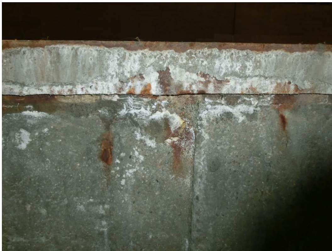
Foto. 83: Detail degradace betonu pod zkorodovaným ocelovým úhelníkem
