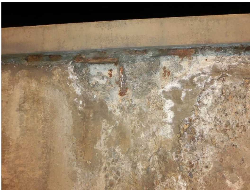
Foto. 72: Detail degradace krycí vrstvy betonu, lokální koroze výztuže
