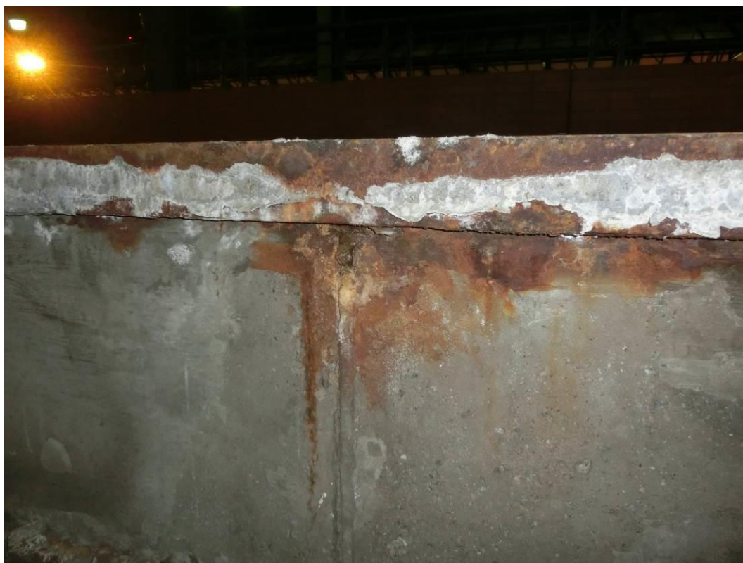
Foto. 10: Detail plošné koroze ocelového úhelníku a degradace betonu pod ním
