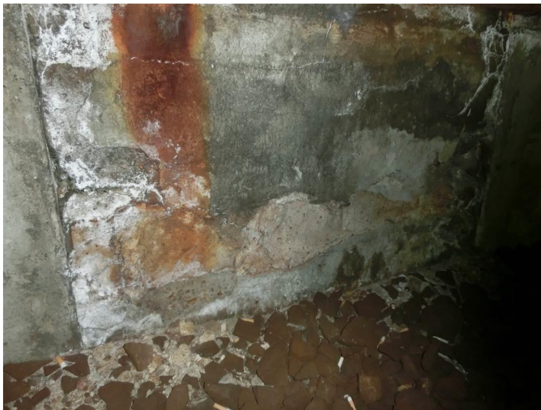
Foto. 43: Detail degradace krycí vrstvy betonu, odpadnutí krycí vrstvy betonu
