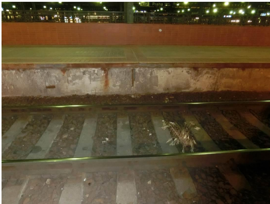
Foto. 109: Pohled na nástupištní zídku – patrná lokální koroze výztuže, degradace povrchu
