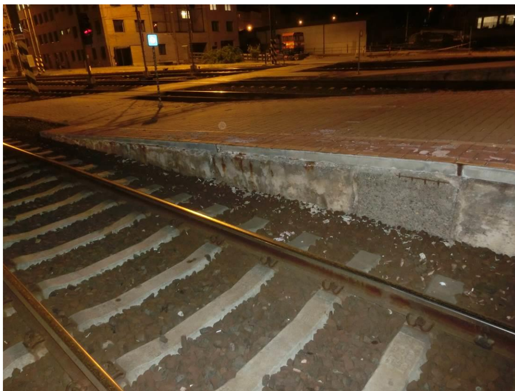
Foto. 18: Pohled na nástupištní zídku – patrná lokální koroze výztuže, degradace krycí vrstvy betonu
