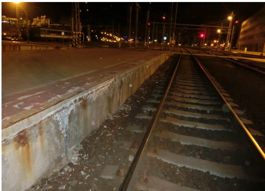
Foto. 38: Pohled na nástupištní zídku – patrná lokální koroze výztuže, degradace krycí vrstvy betonu
