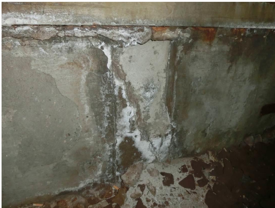
Foto. 23: Detail degradace krycí vrstvy betonu
