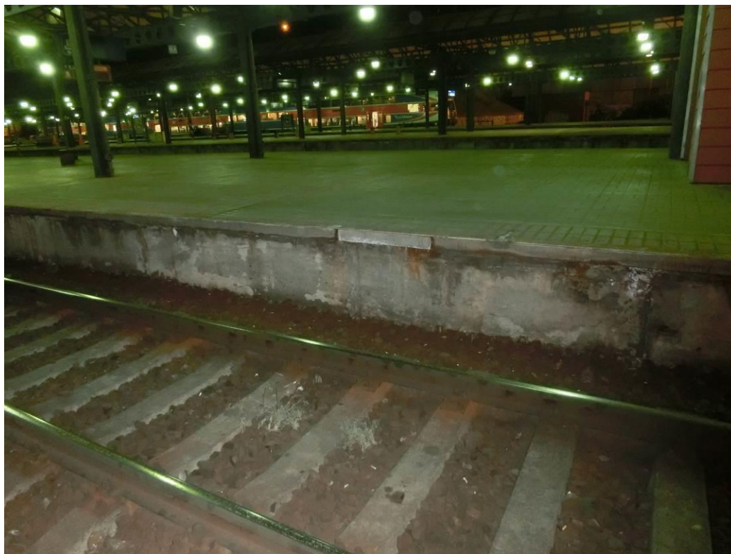
Foto. 3: Pohled na nástupištní zídku – degradace krycí vrstvy betonu - lokální odpadávání betonu, lokální koroze výztuže a ocelového úhelníku
