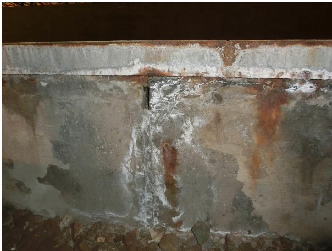
Foto. 11: Detail plošné koroze ocelového úhelníku a degradace betonu pod ním
