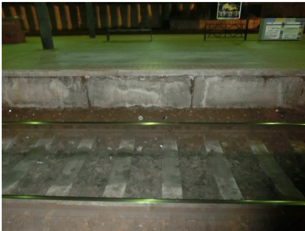
Foto. 79: Degradace betonu pod ocelovým úhelníkem
