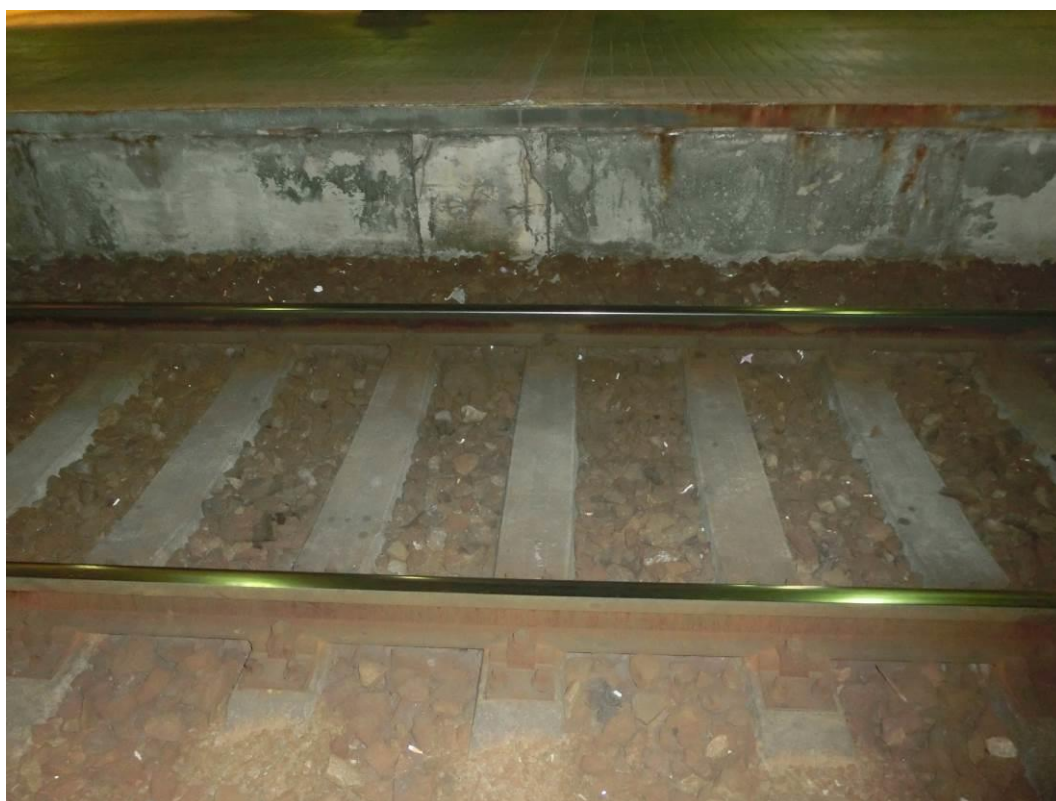
Foto. 87: Pohled na nástupištní zídku – patrná degradace krycí vrstvy betonu vrstvy
