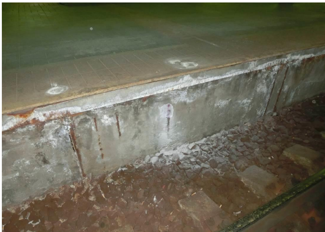
Foto. 24: Pohled na nástupištní zídku – patrná lokální koroze výztuže, degradace krycí vrstvy betonu, místy nulové krytí výztuže betonem
