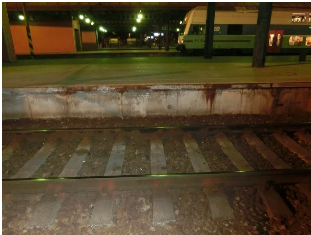
Foto. 95: Patrná degradace betonu pod ocelovým úhelníkem vlivem koroze
