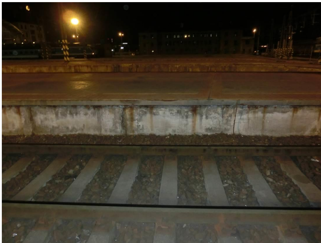
Foto. 73: Pohled na nástupištní zídku – patrná degradace krycí vrstvy betonu
