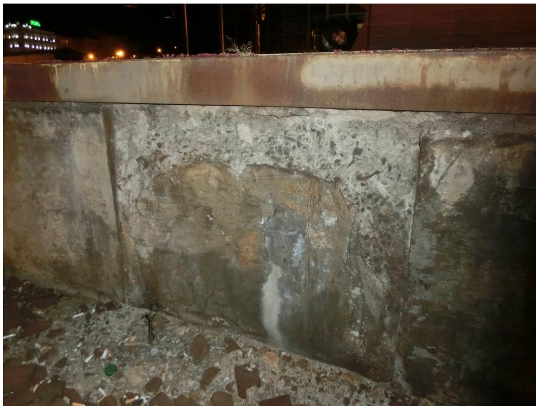
Foto. 53: Pohled na nástupištní zídku – patrná degradace krycí vrstvy betonu
