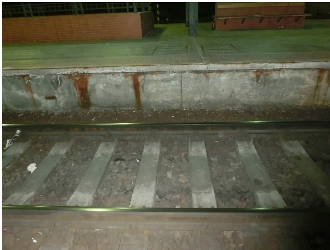
Foto. 81: Pohled na nástupištní zídku – patrná degradace krycí vrstvy betonu
