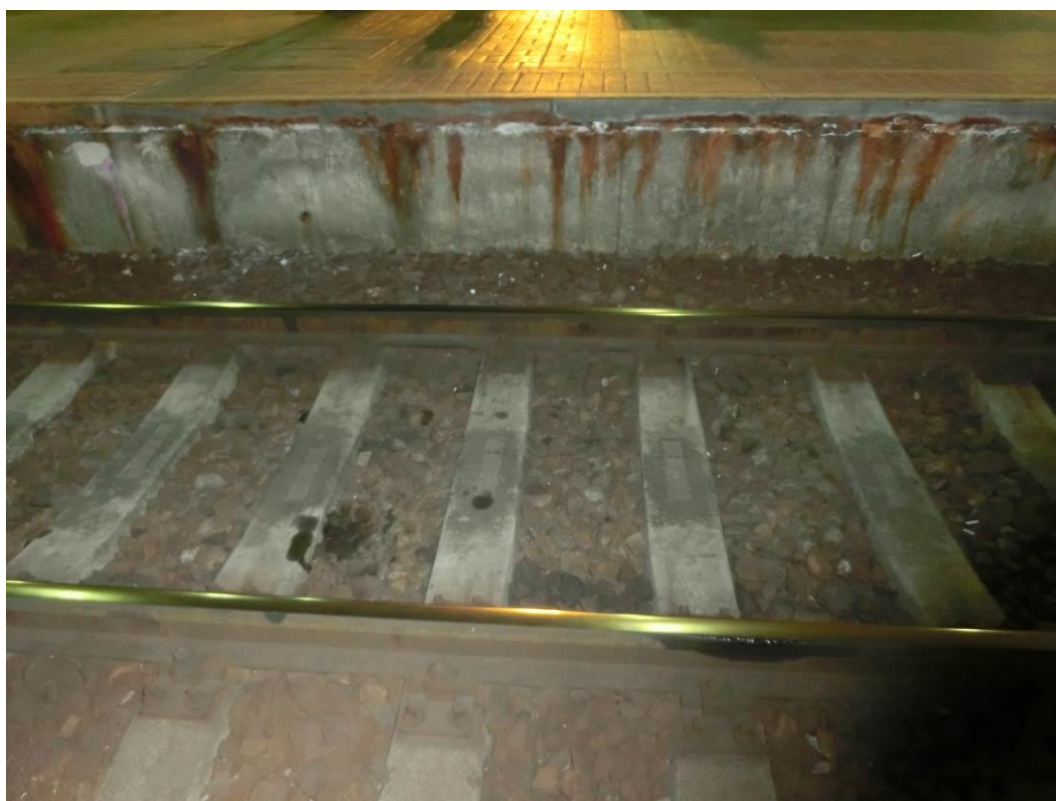
Foto. 85: Detail degradace betonu pod zkorodovaným ocelovým úhelníkem
