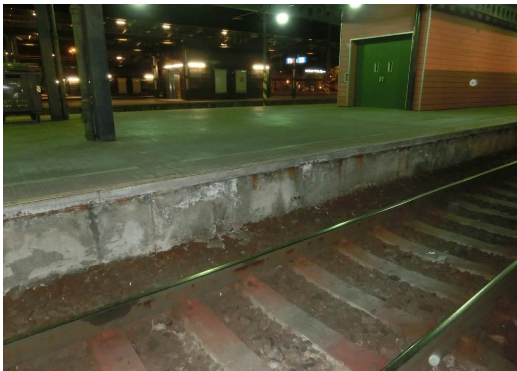
Foto. 34: Pohled na nástupištní zídku – patrná lokální koroze výztuže, degradace krycí vrstvy betonu
