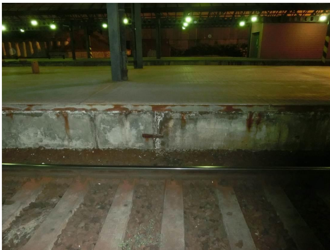
Foto. 42: Pohled na nástupištní zídku – patrná lokální koroze výztuže, degradace krycí vrstvy betonu
