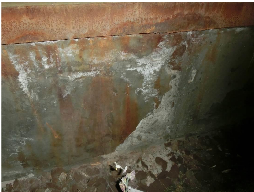
Foto. 48: Detail plošné koroze ocelového úhelníku a degradace betonu pod ním
