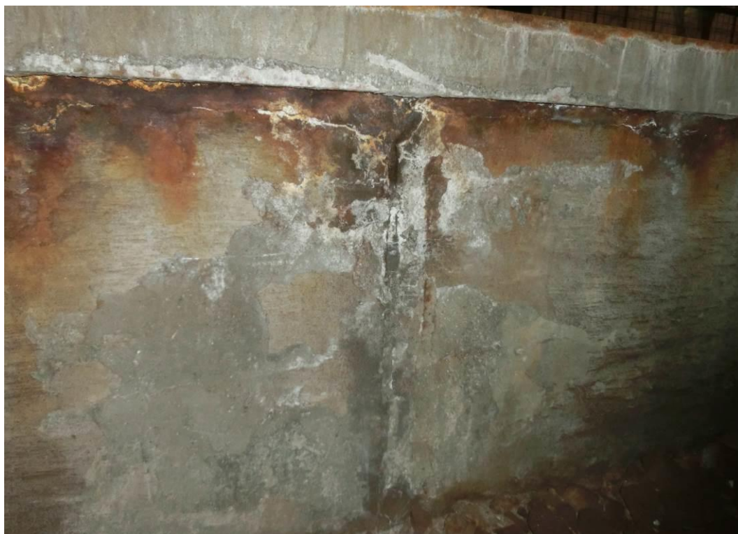
Foto. 26: Detail plošné koroze ocelového úhelníku, degradace betonu pro úhelníkem
