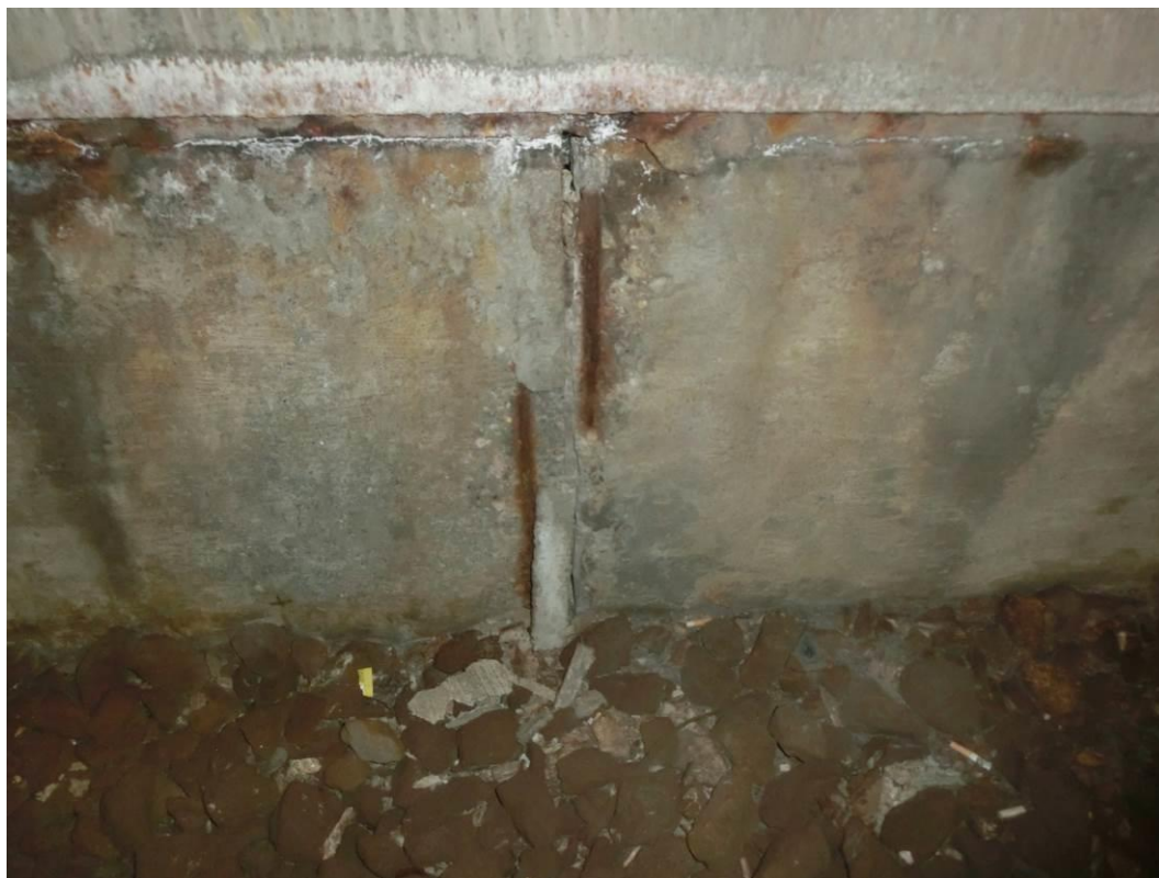
Foto. 33: Detail lokální koroze ocelové výztuže a ocelového úhelníku
