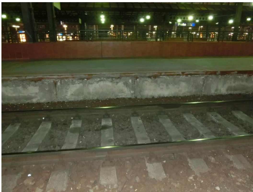
Foto. 62: Pohled na nástupištní zídku – patrná degradace krycí vrstvy betonu
