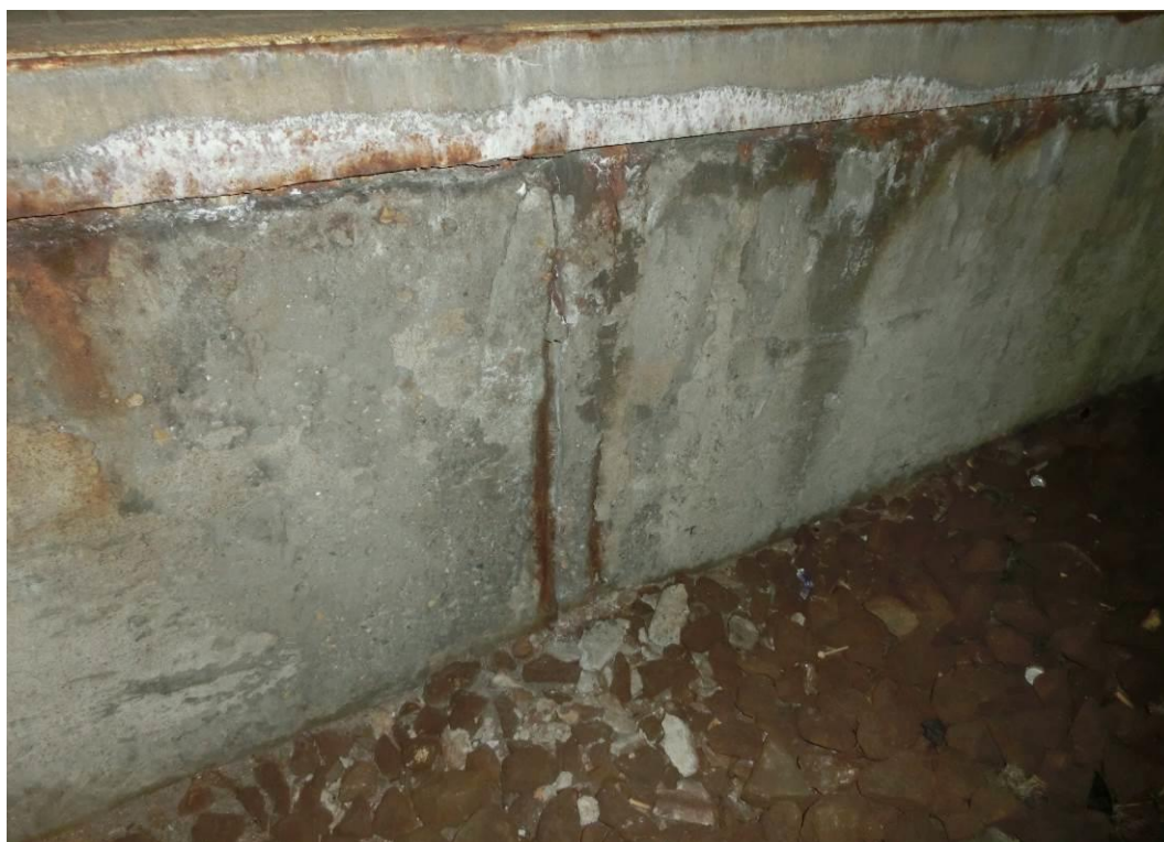
Foto. 30: Detail koroze výztuže, degradace krycí vrstvy betonu
