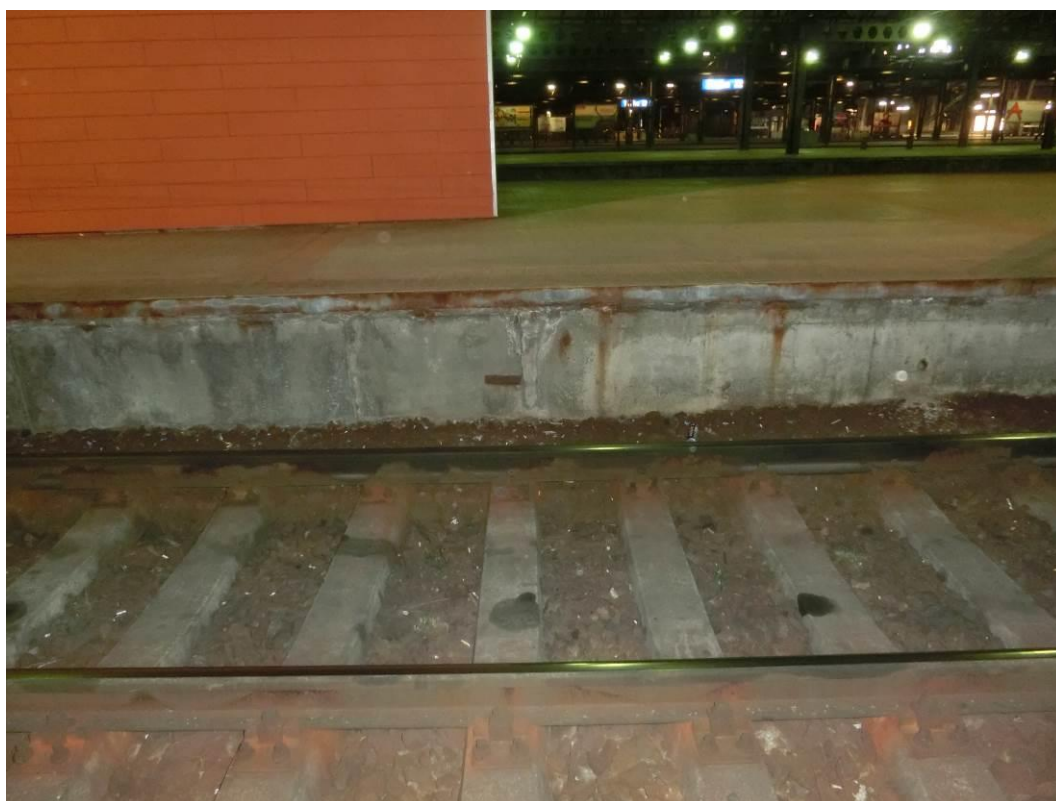
Foto. 59: Pohled na plošnou korozi ocelového úhelníku, degradace betonu pod úhelníkem
