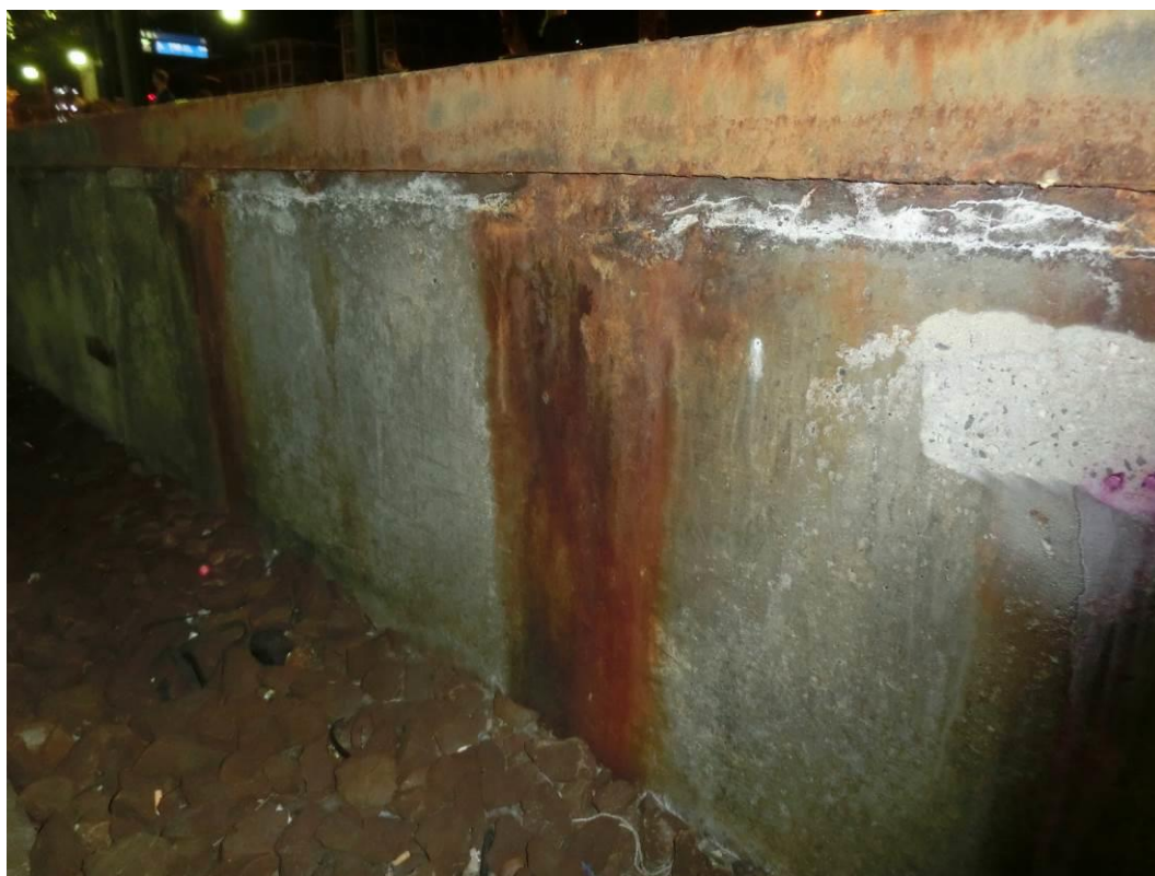
Foto. 86: Detail degradace betonu pod zkorodovaným ocelovým úhelníkem
