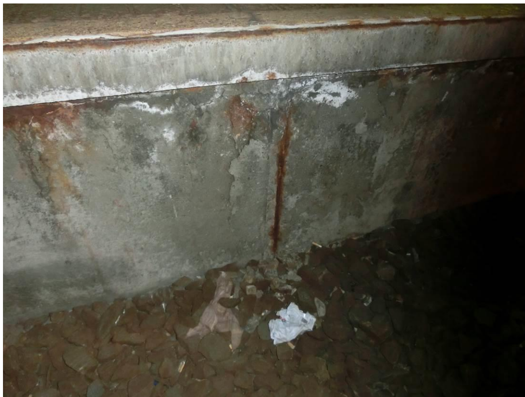
Foto. 103: Detail koroze výztuže
