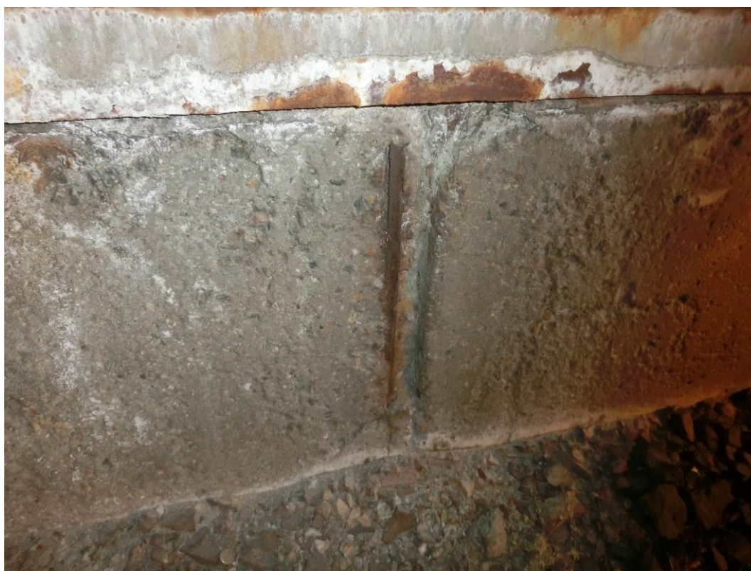
Foto. 105: Detail koroze výztuže
