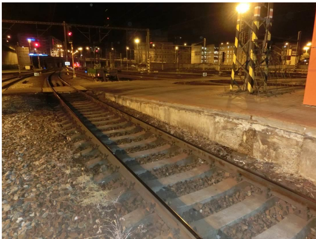
Foto. 57: Pohled na nástupištní zídku – patrná degradace krycí vrstvy betonu
