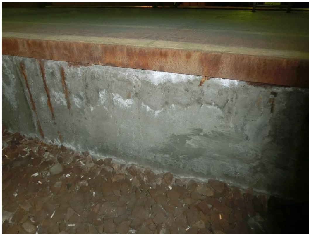
Foto. 50: Plošná koroze ocelového úhelníku, degradace krycí vrstvy betonu, lokální koroze ocelové výztuže
