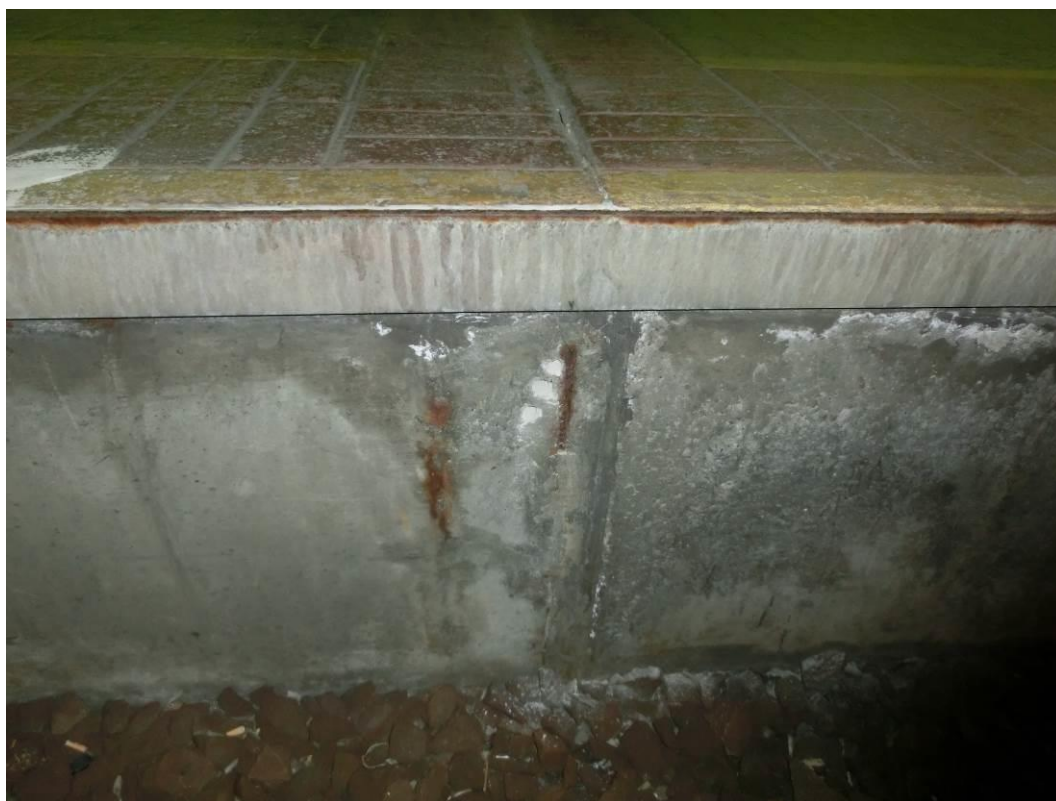
Foto. 80: Detail koroze výztuže
