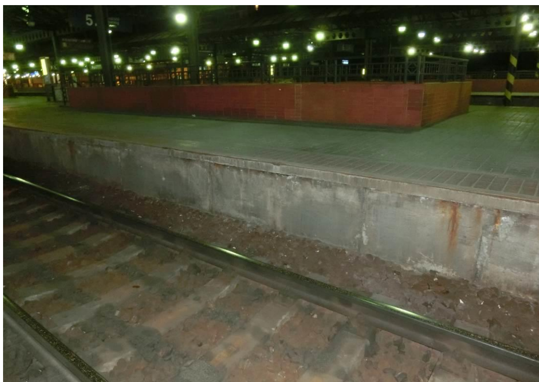
Foto. 6: Pohled na nástupištní zídku – degradace krycí vrstvy betonu - lokální odpadávání betonu, lokální koroze výztuže a ocelového úhelníku
