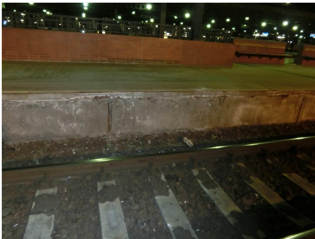
Foto. 106: Pohled na nástupištní zídku – patrná lokální koroze výztuže, degradace povrchu
