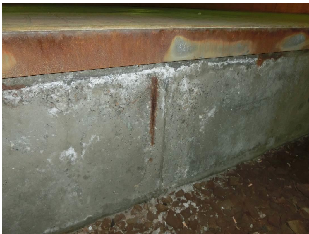
Foto. 66: Detail degradace krycí vrstvy betonu, lokální koroze výztuže
