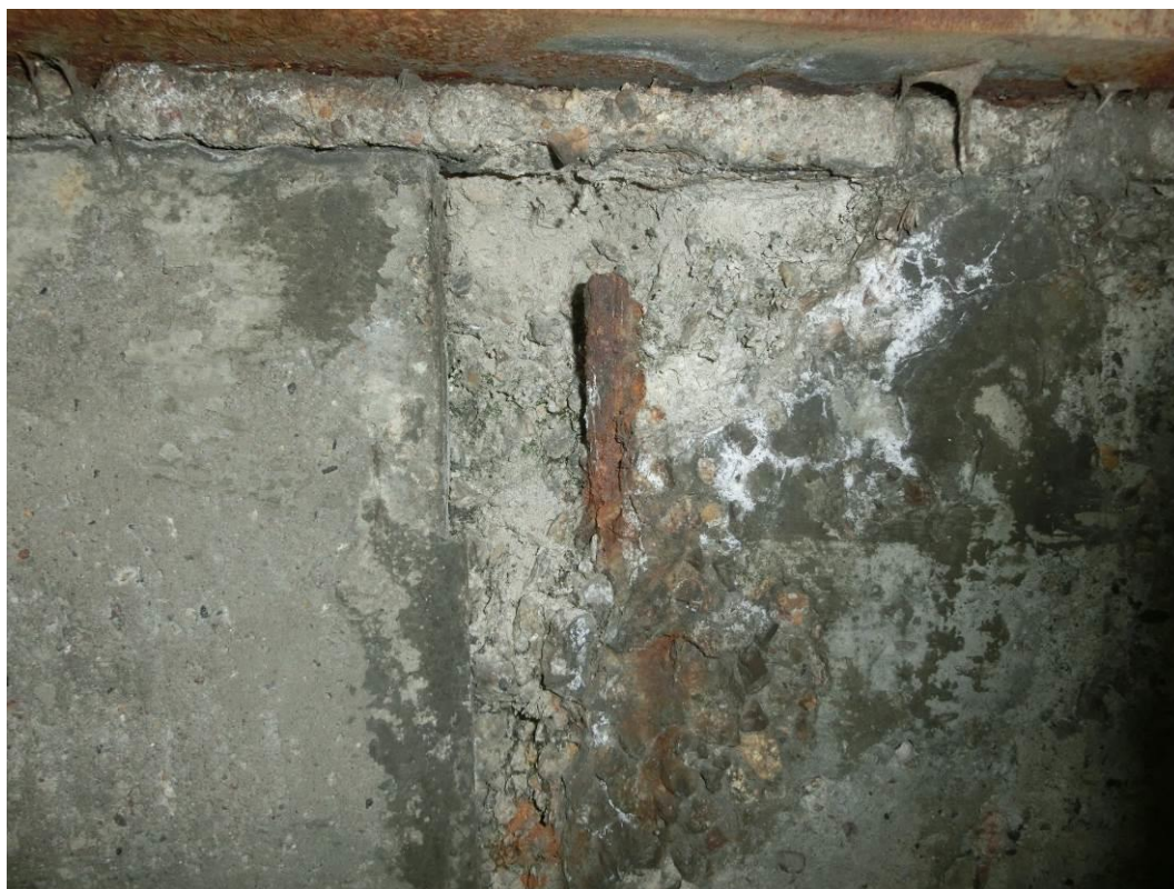
Foto. 46: Detail koroze ocelové výztuže, odpadnutí krycí vrstvy betonu
