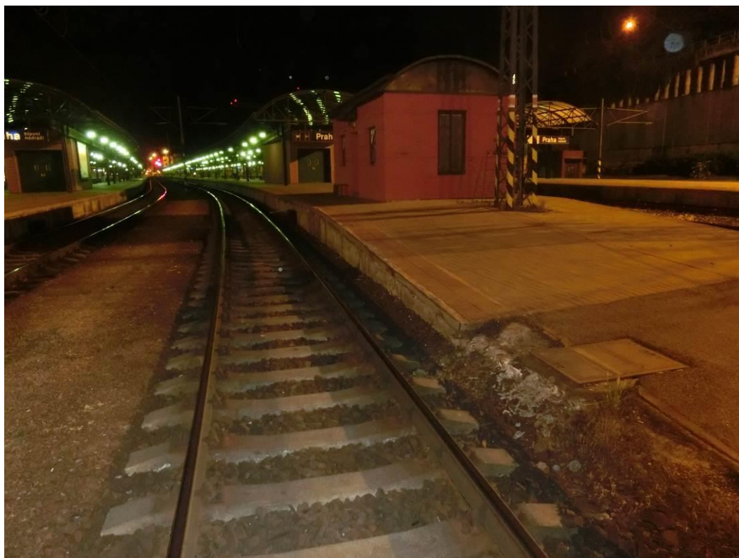
Foto. 39: Pohled na nástupištní zídku – patrná lokální koroze výztuže, degradace krycí vrstvy betonu
