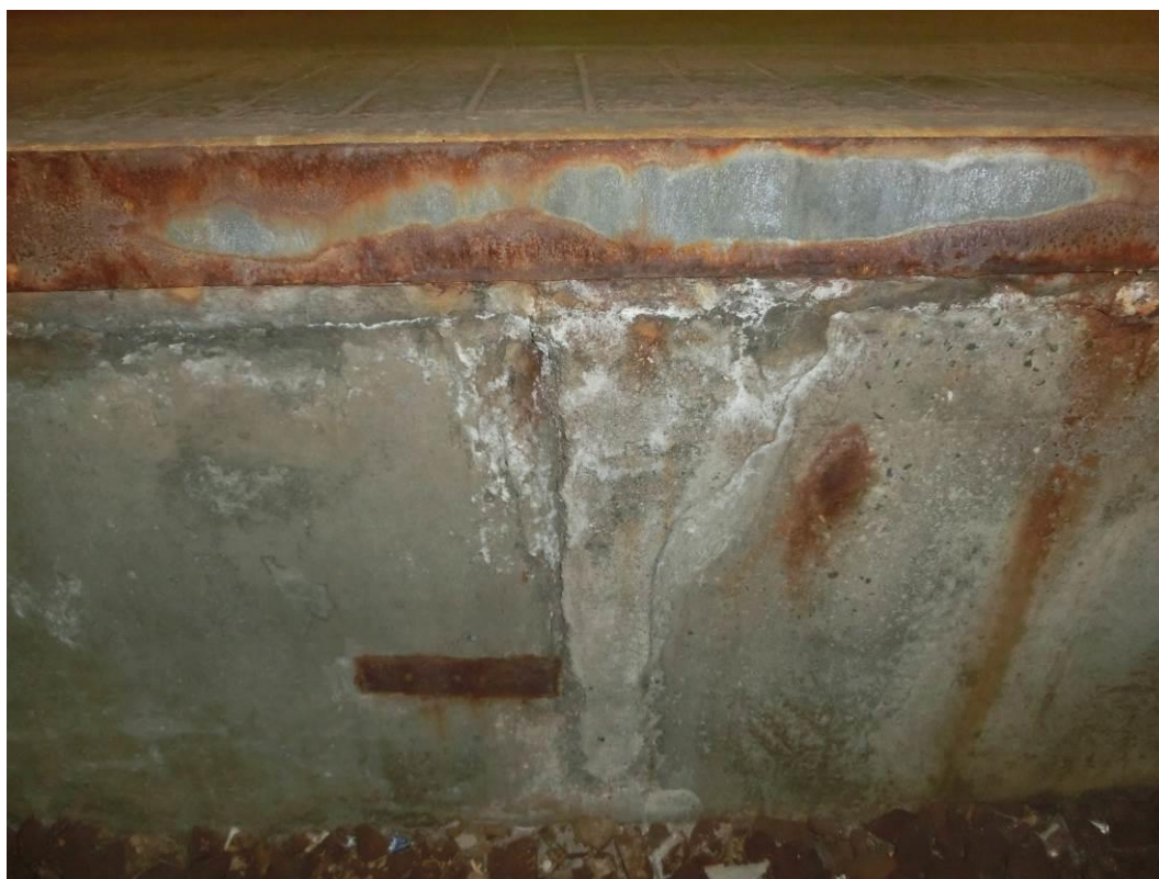
Foto. 60: Detail plošné koroze ocelového úhelníku, degradace betonu pod úhelníkem
