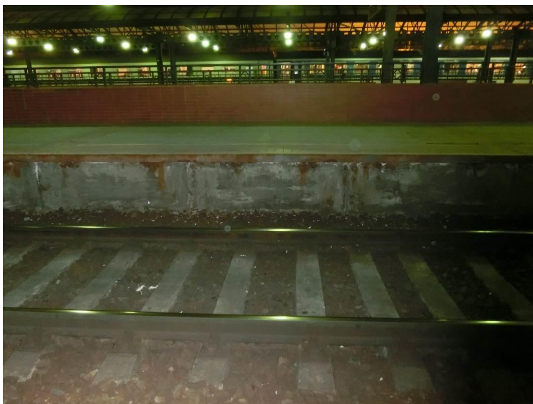
Foto. 51: Pohled na nástupištní zídku – patrná lokální koroze výztuže, degradace krycí vrstvy betonu
