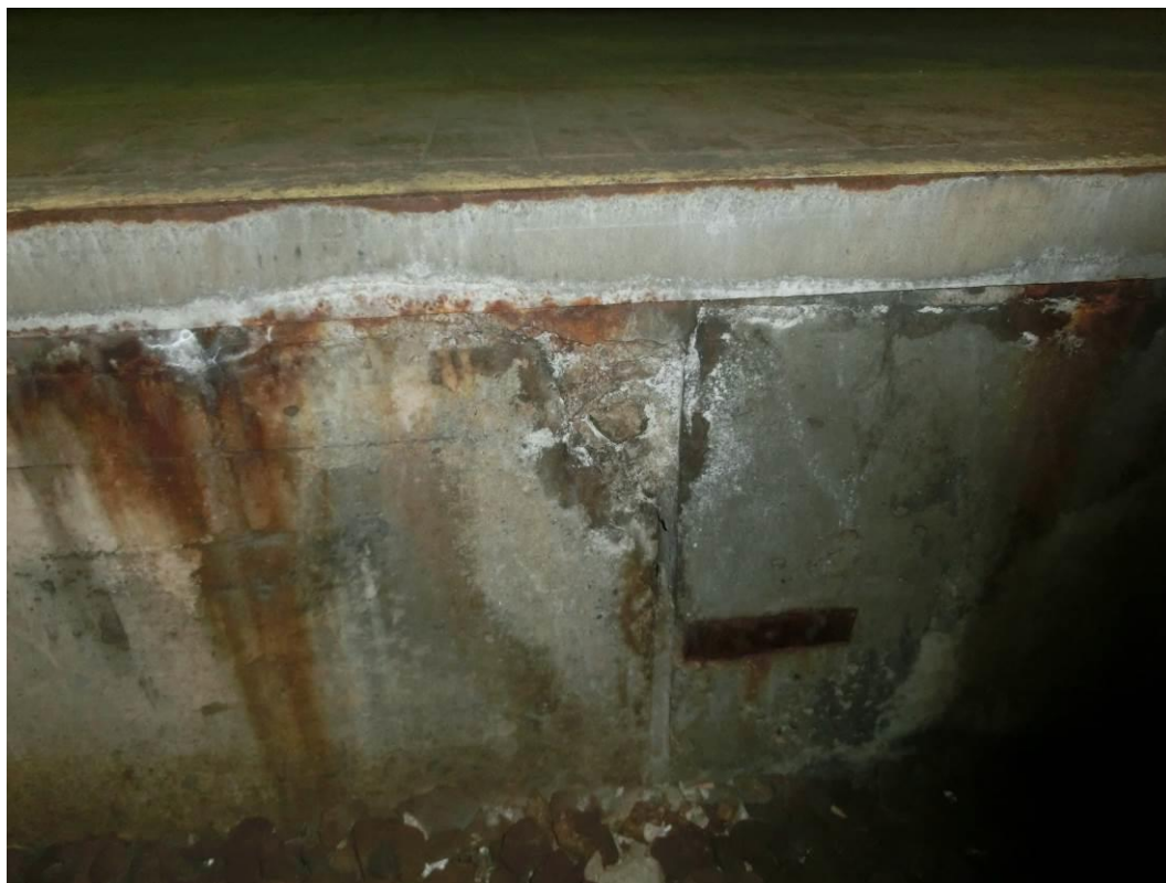
Foto. 77: Detail odpadávání krycí vrstvy betonu a jeho degradace
