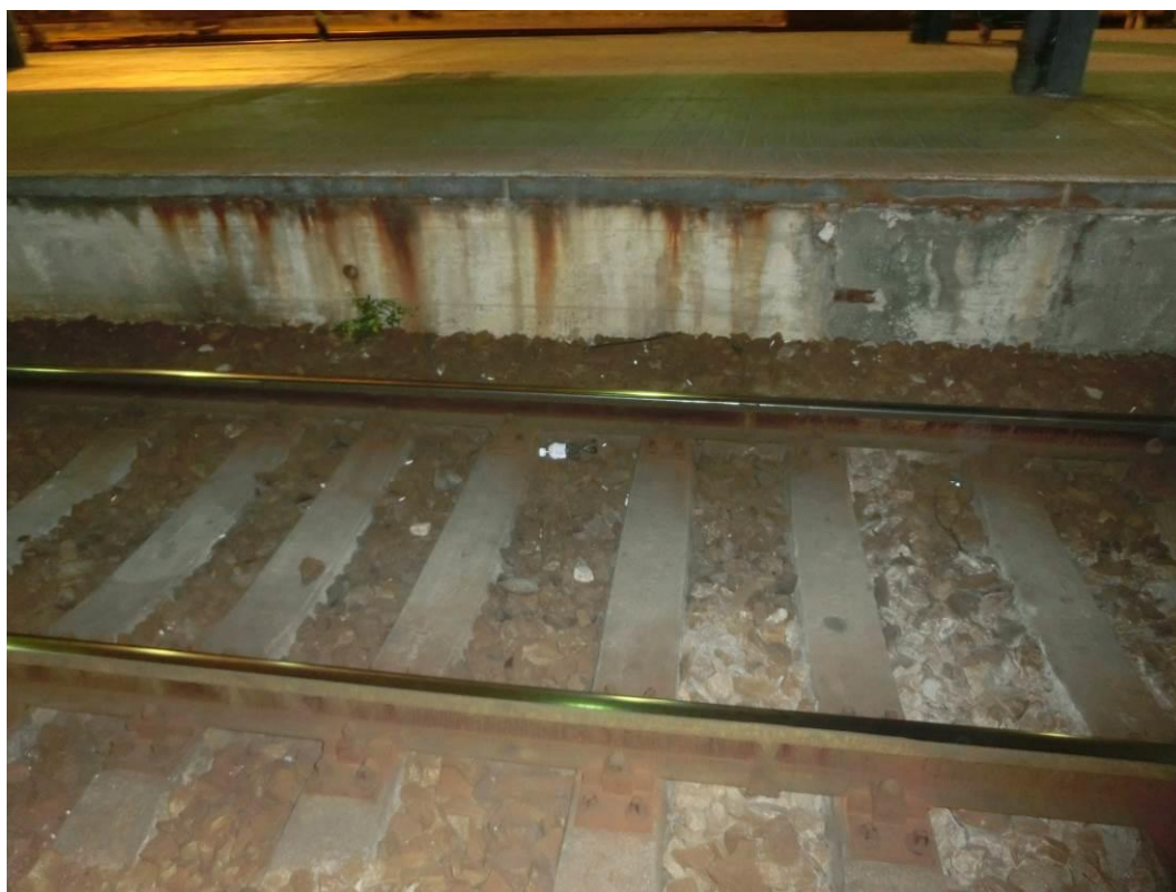
Foto. 88: Pohled na nástupištní zídku – patrná degradace krycí vrstvy betonu vrstvy
