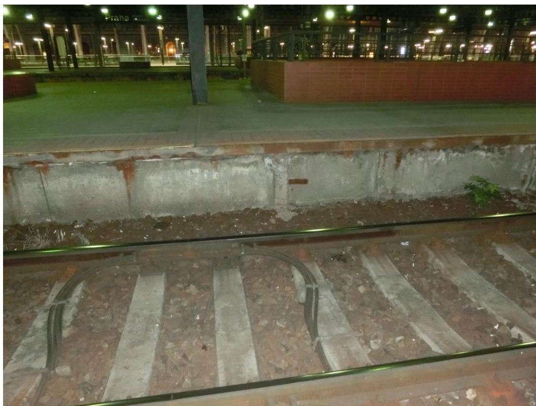
Foto. 64: Pohled na nástupištní zídku – patrná lokální koroze výztuže, degradace povrchu
