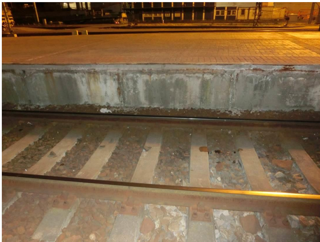
Foto. 89: Pohled na nástupištní zídku – patrná degradace krycí vrstvy betonu
