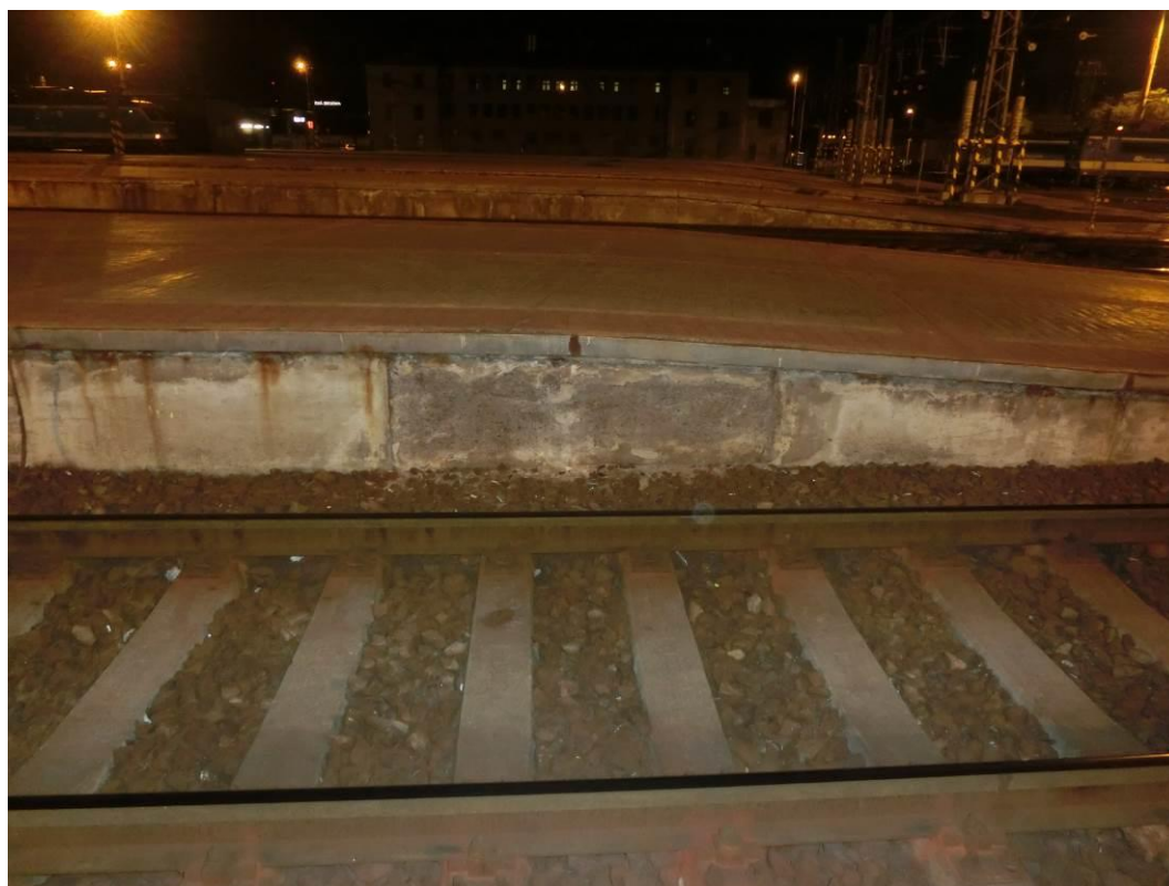
Foto. 74: Pohled na nástupištní zídku – patrná degradace krycí vrstvy betonu
