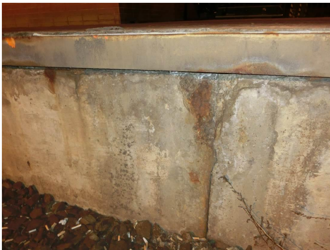
Foto. 70: Detail degradace krycí vrstvy betonu, lokální koroze výztuže
