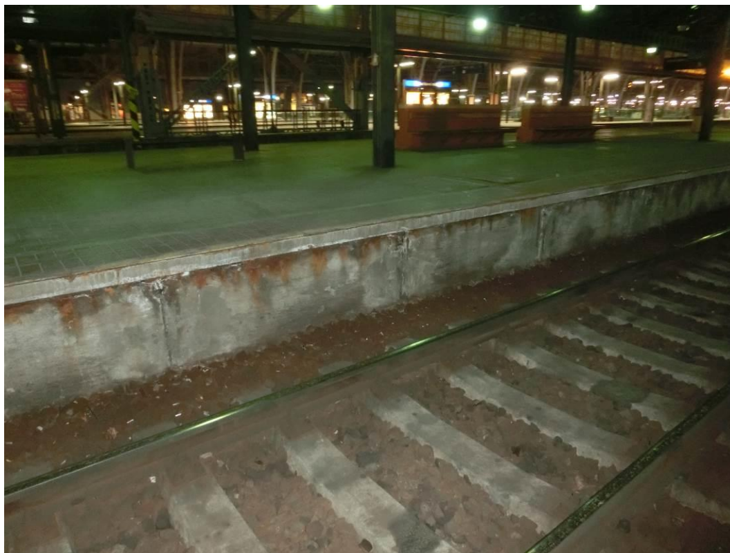
Foto. 25: Pohled na nástupištní zídku – degradace krycí vrstvy betonu
