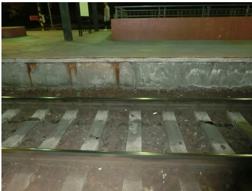
Foto. 82: Pohled na nástupištní zídku – patrná degradace krycí vrstvy betonu
