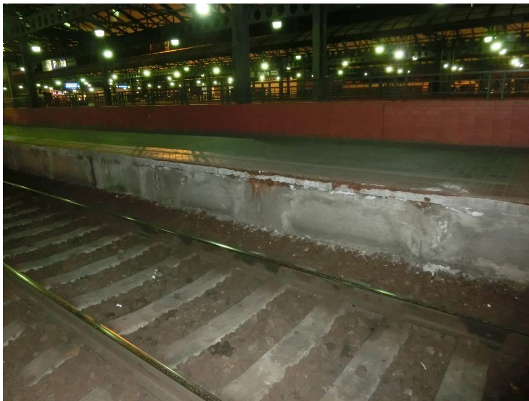
Foto. 9: Pohled na nástupištní zídku – degradace krycí vrstvy betonu - lokální odpadávání betonu, lokální koroze výztuže a ocelového úhelníku
