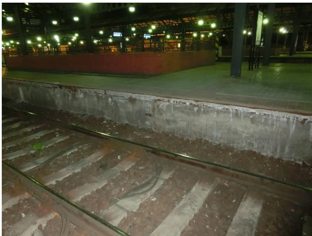
Foto. 8: Pohled na nástupištní zídku – degradace krycí vrstvy betonu - lokální odpadávání betonu, lokální koroze výztuže a ocelového úhelníku
