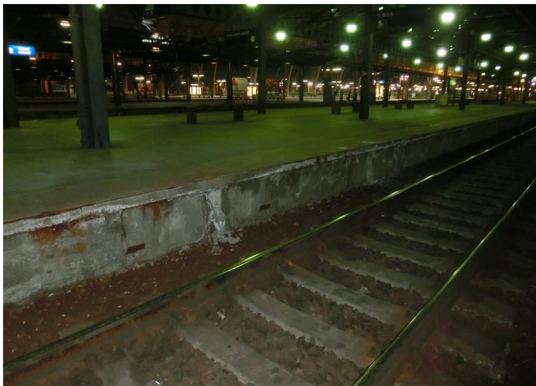
Foto. 22: Pohled na nástupištní zídku – patrná lokální koroze výztuže, degradace krycí vrstvy betonu, koroze ocelového úhelníku
