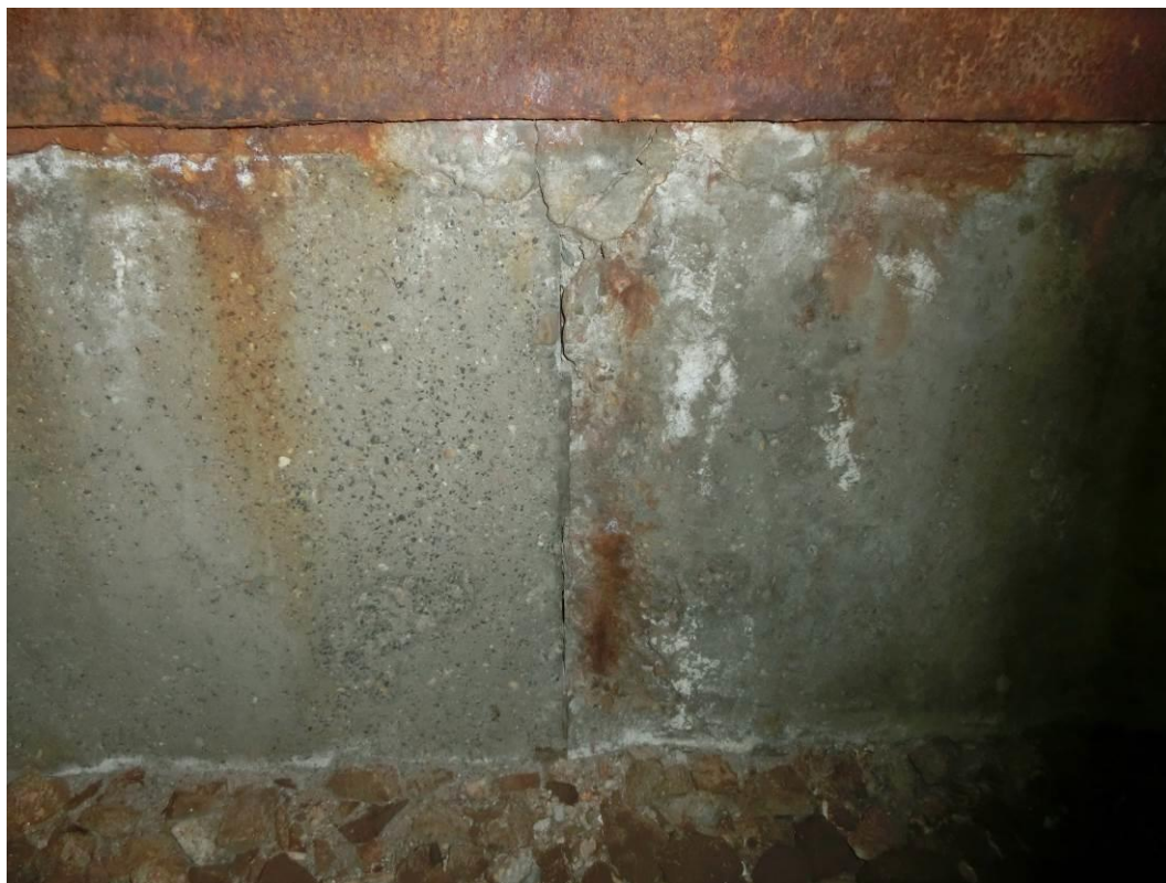
Foto. 47: Detail degradace krycí vrstvy betonu, lokální koroze výztuže
