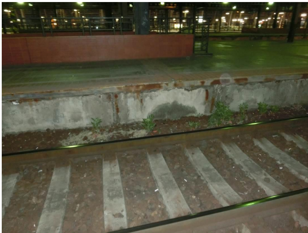
Foto. 65: Detail degradace krycí vrstvy betonu, lokální koroze výztuže
