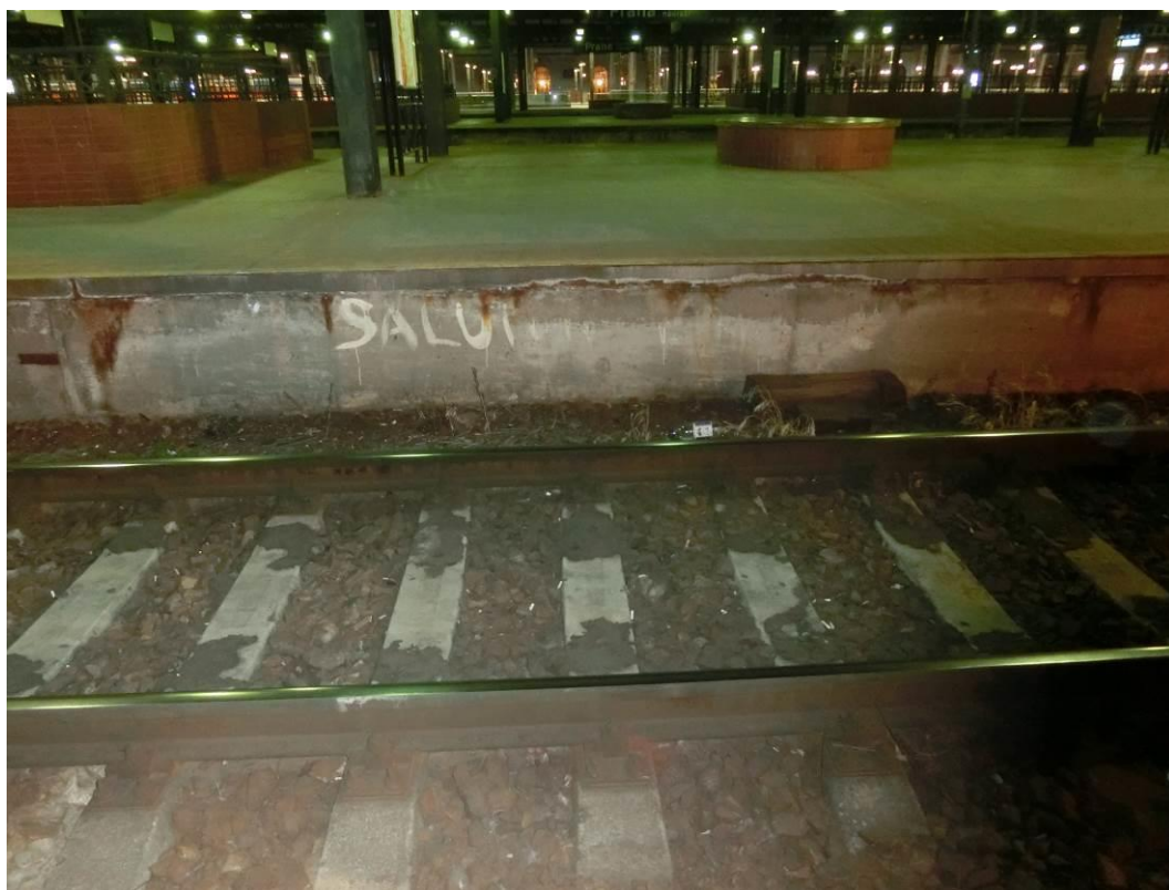
Foto. 104: Patrná degradace betonu pod ocelovým úhelníkem, odpadávání betonu
