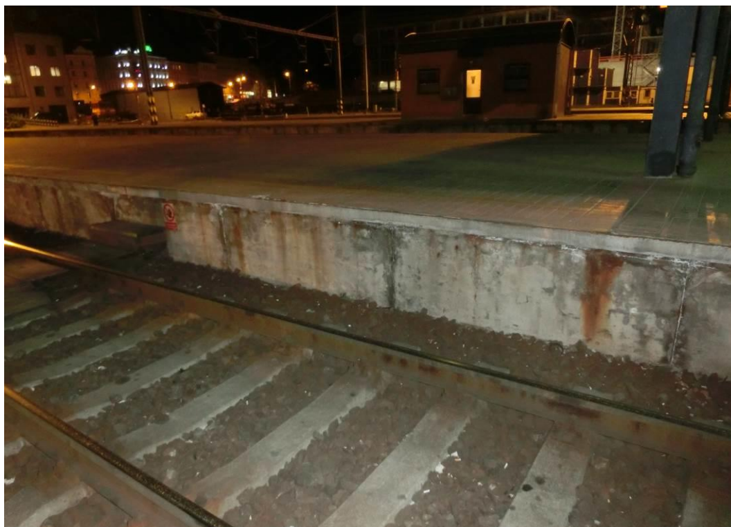
Foto. 14: Pohled na nástupištní zídku – degradace krycí vrstvy betonu, lokální odpadávání krycí vrstvy, lokální koroze výztuže a ocelového úhelníku
