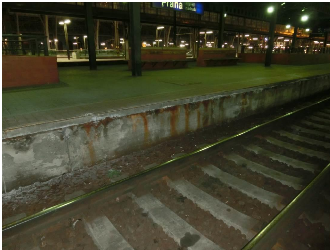
Foto. 27: Pohled na nástupištní zídku – degradace krycí vrstvy betonu
