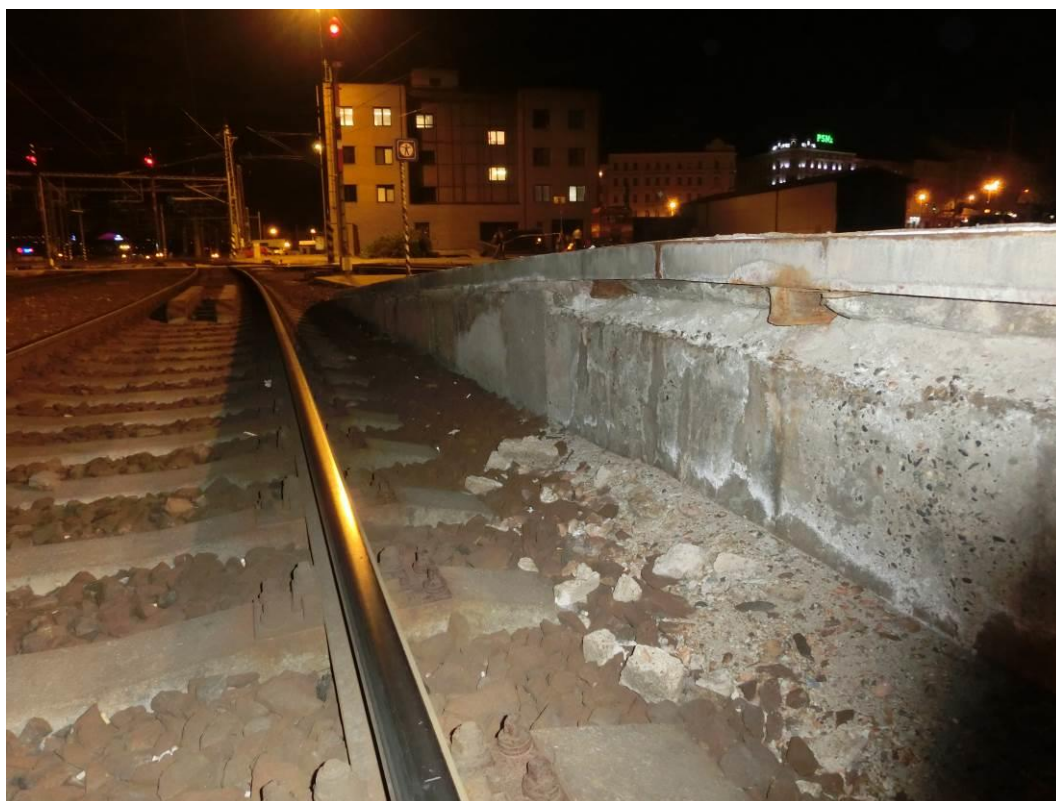
Foto. 92: Detail degradace betonu pod zkorodovaným úhelníkem
