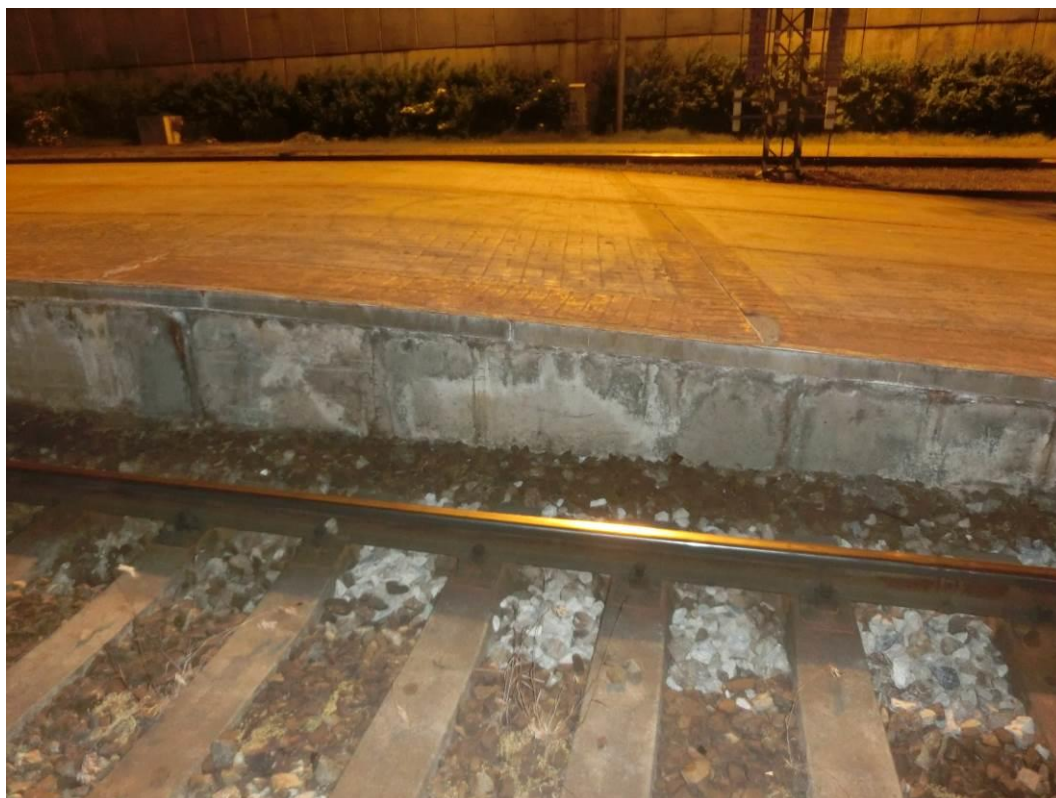
Foto. 75: Pohled na nástupištní zidku – patrná degradace krycí vrstvy betonu
