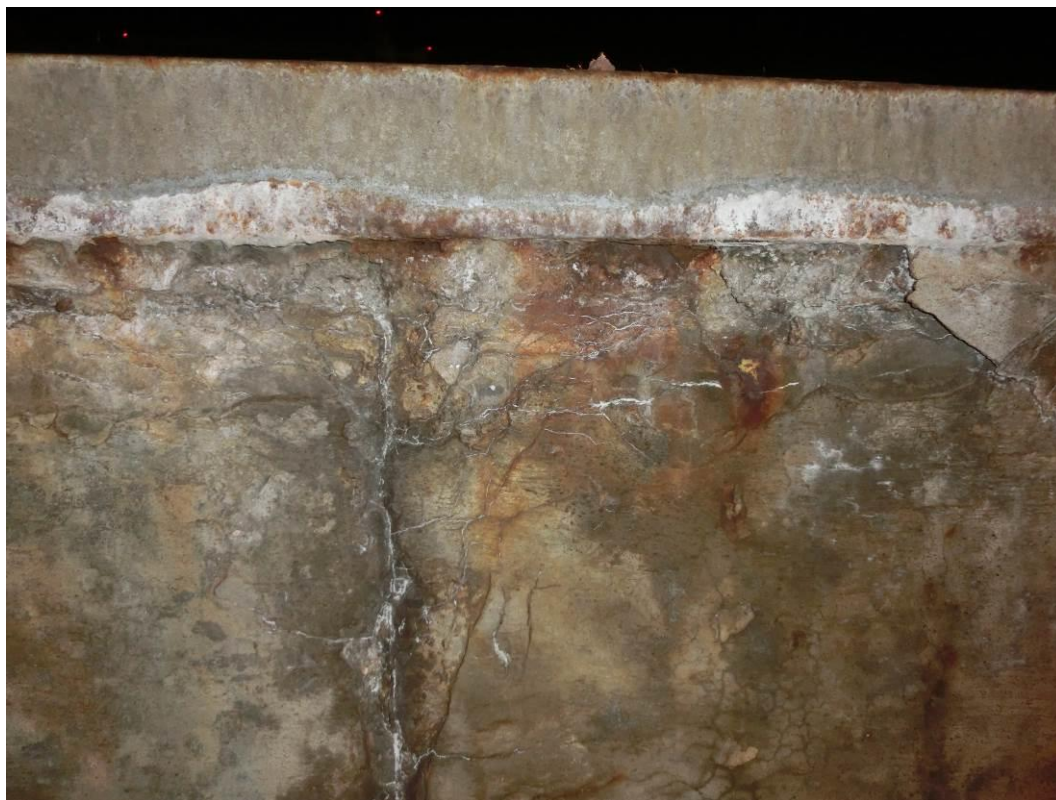
Foto. 15: Detail trhlin v krycí vrstvě betonu, degradace betonu pod ocelovým úhelníkem
