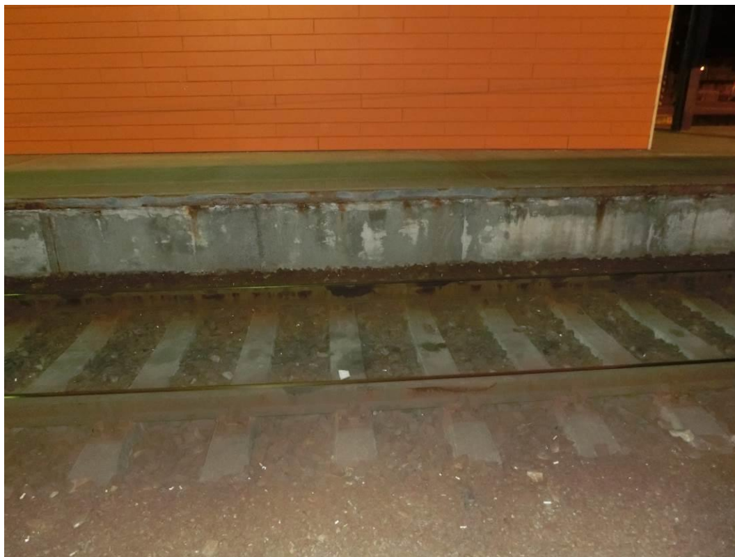
Foto. 69: Pohled na nástupištní zídku – patrná degradace krycí vrstvy betonu
