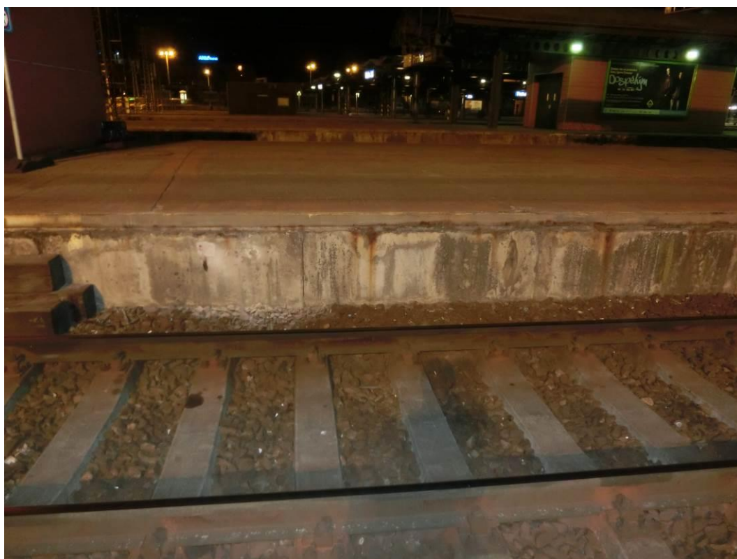
Foto. 58: Pohled na nástupištní zídku – patrná degradace krycí vrstvy betonu
