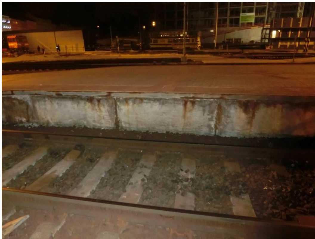
Foto. 55: Pohled na nástupištní zídku – patrná lokální koroze výztuže, degradace krycí vrstvy betonu, koroze ocelového úhelníku
