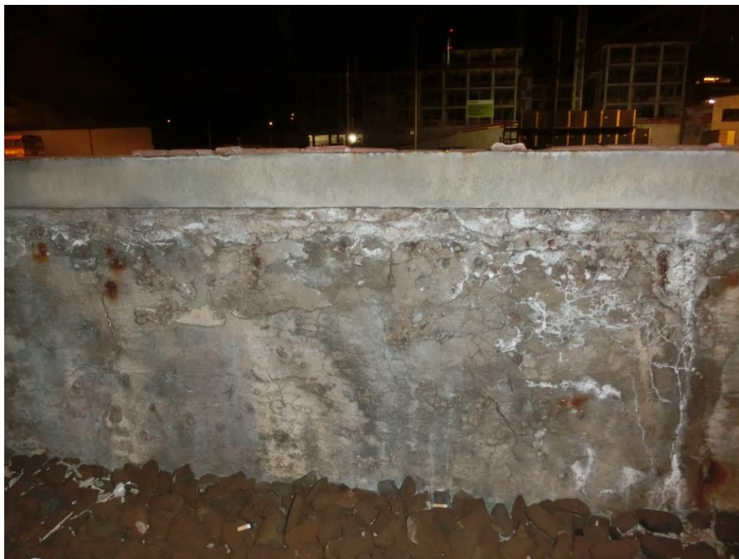
Foto. 17: Degradace krycí vrstvy betonu pod ocelovým úhelníkem
