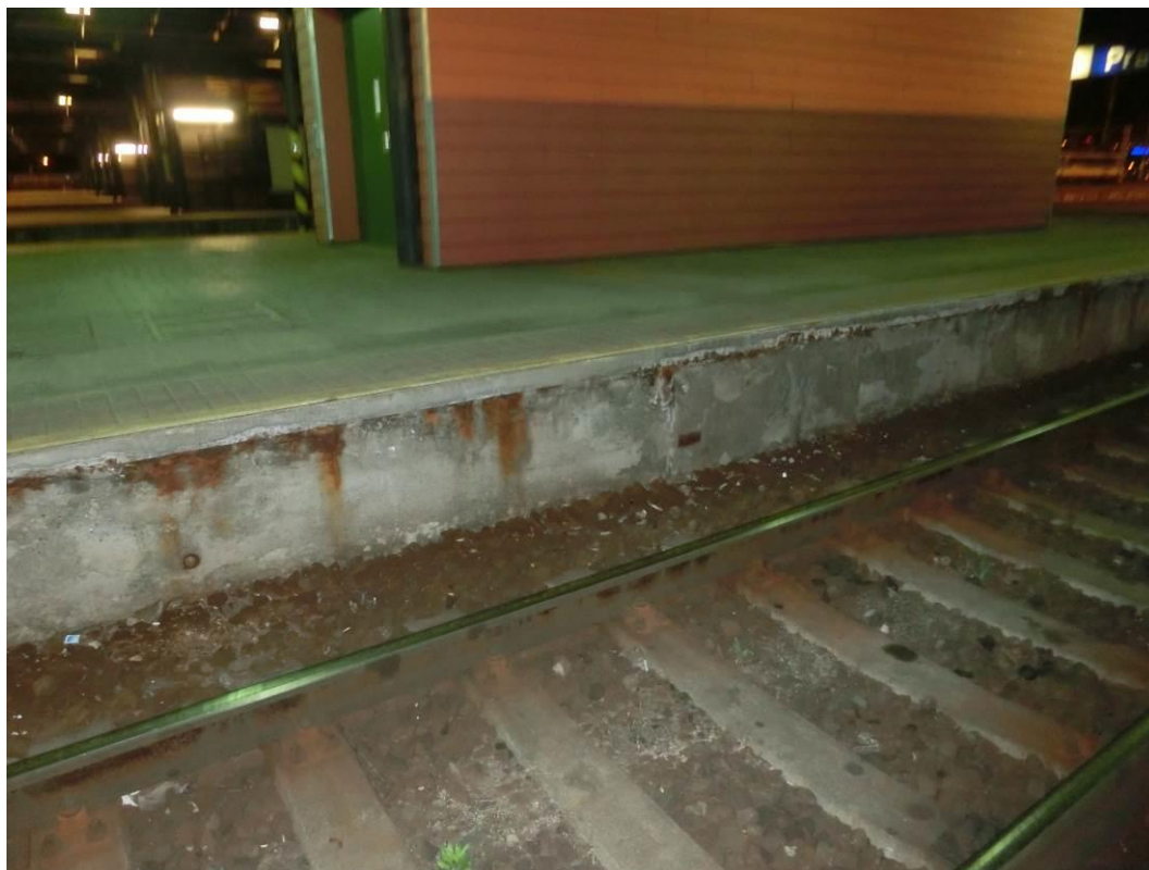
Foto. 35: Pohled na nástupištní zídku – patrná lokální koroze úhelníku, degradace krycí vrstvy betonu
