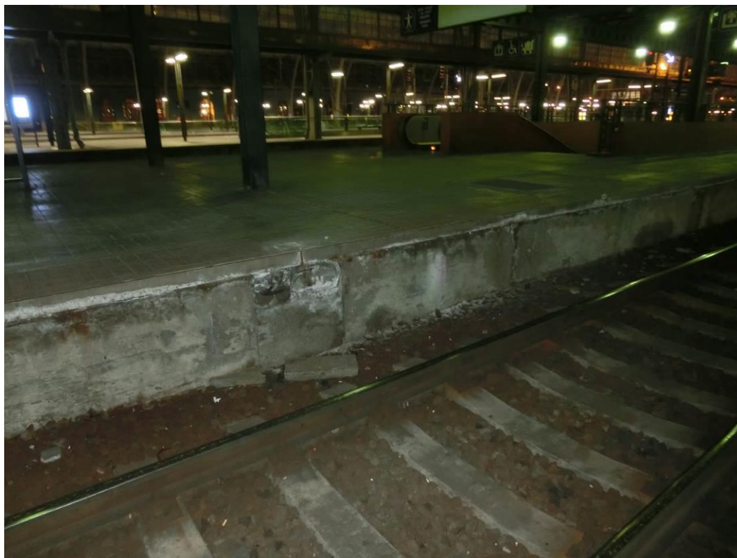
Foto. 29: Pohled na nástupištní zídku – patrná lokální koroze výztuže, degradace krycí vrstvy betonu
