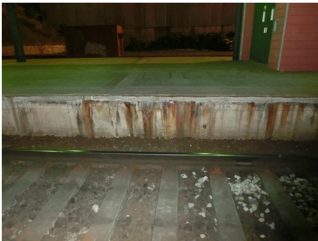
Foto. 78: Degradace betonu pod ocelovým úhelníkem, plošná koroze úhelníku
