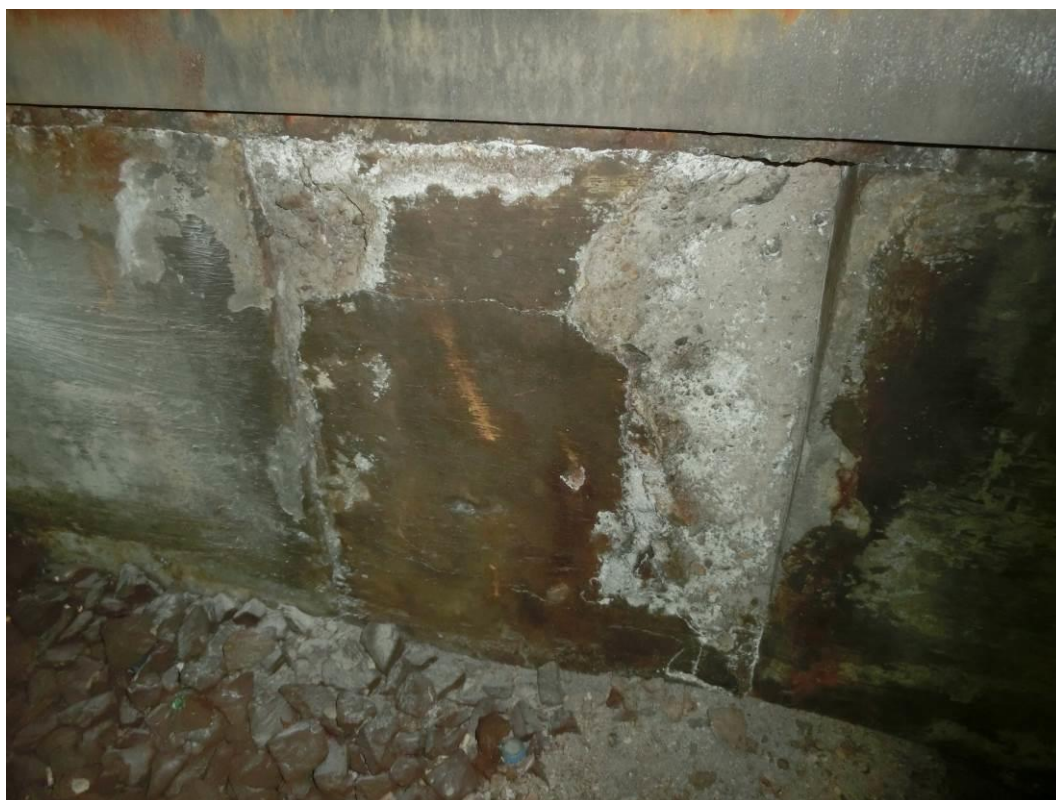
Foto. 52: Pohled na nástupištní zídku – patrná degradace krycí vrstvy betonu
