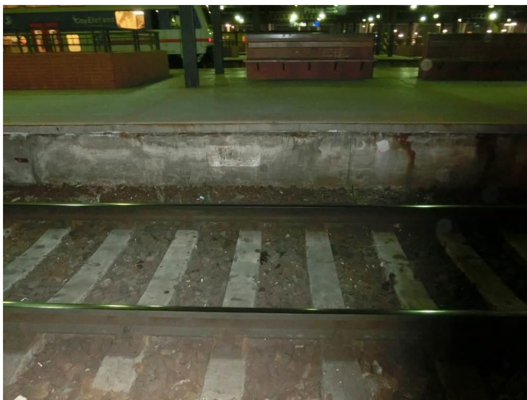
Foto. 99: Pohled na nástupištní zídku – patrná lokální koroze výztuže, degradace povrchu
